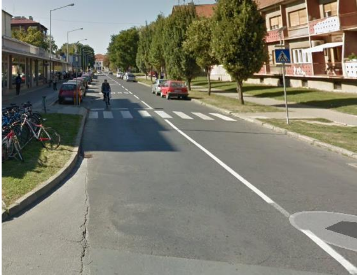
Slika 25. Trenutno stanje ulice Ivana Meštrovića u Koprivnici
