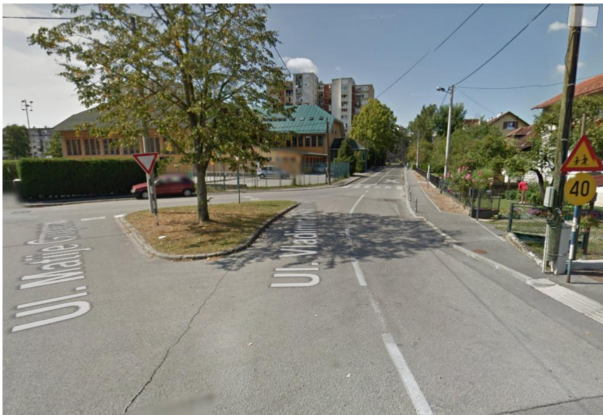
Slika 34. Postojeće stanje ulice Vladimira Nazora u gradu Zadaru
