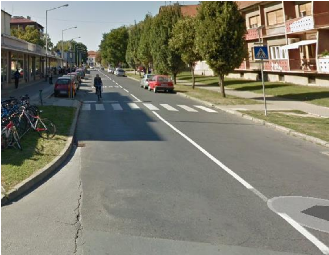
Slika 25. Trenutno stanje ulice Ivana Meštrovića u Koprivnici
