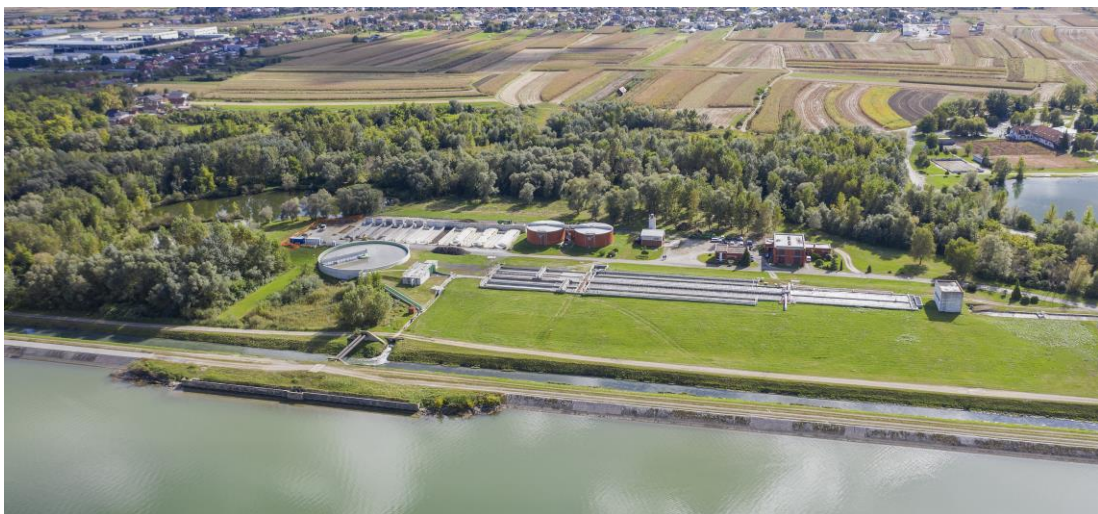
Slika 1.2. UPOV Varaždin – biološki dio pročištača
