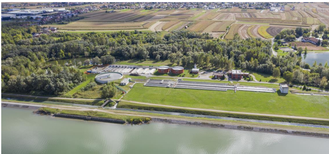
Slika 1.2. UPOV Varaždin – biološki dio pročištača
