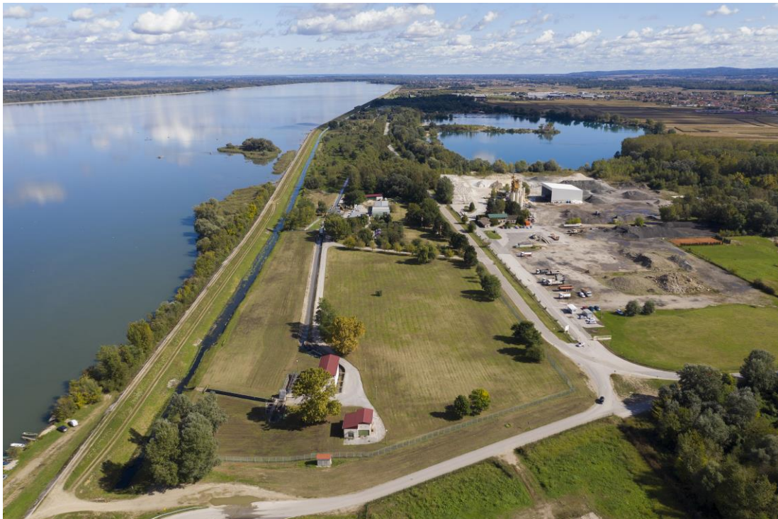
Slika 1.1. UPOV Varaždin – glavni kolektor, kišni preljev s prijammnikom, Crpna stanica, trapezni kanal
