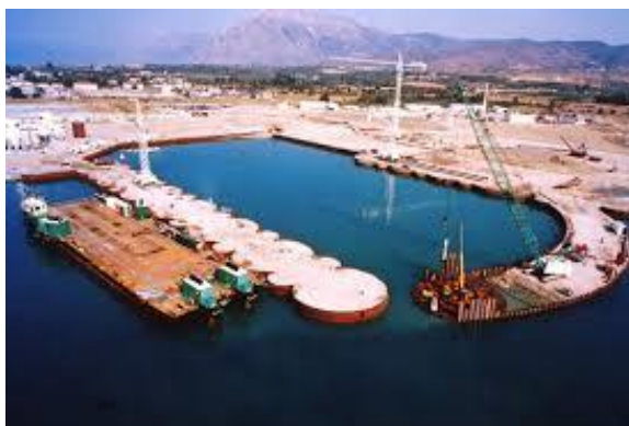
Slika 2.8: Izvođenje kružnih ćelija koferdam u vodi (Izvor:
