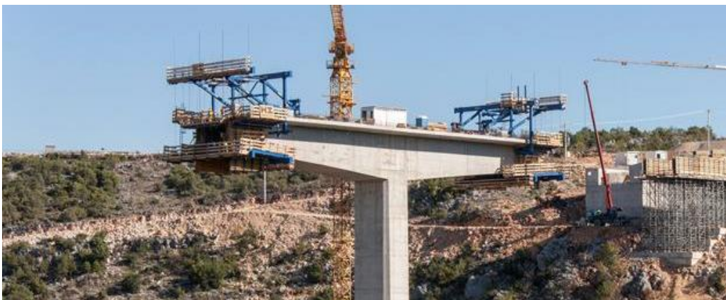
Slika 2.10. Krletka za konzolnu gradnju
