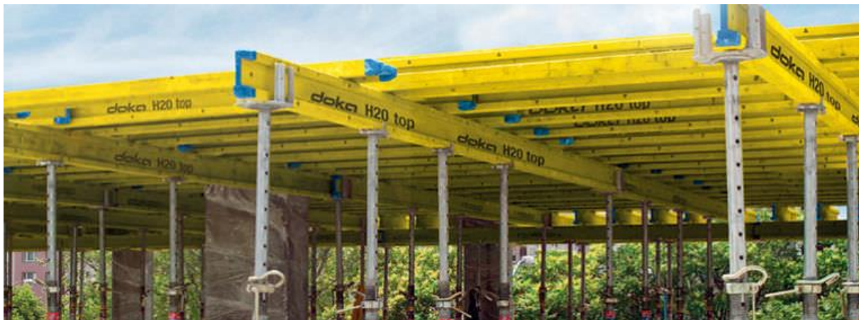
Slika 2.5. Stropna oplata Dokaflex
