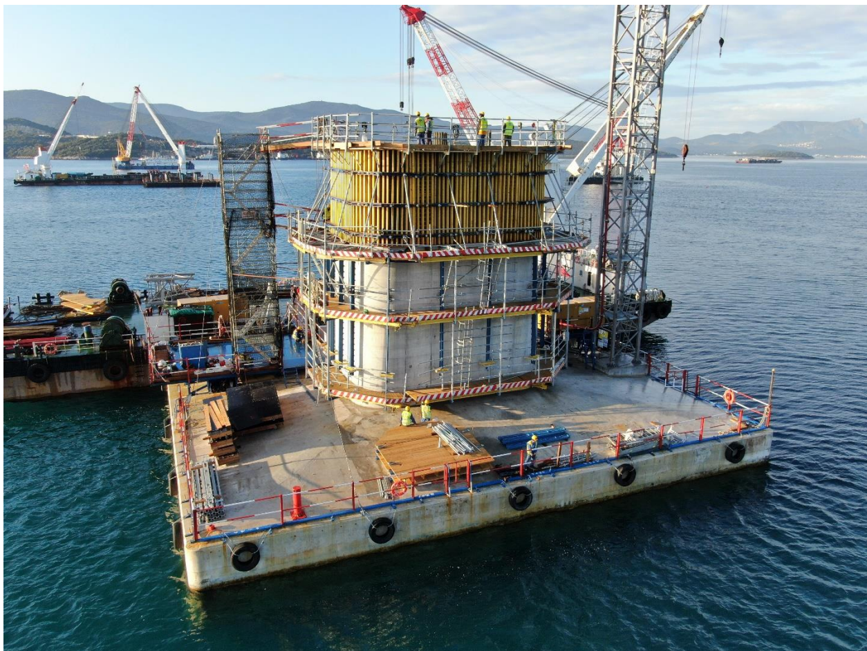
Slika 4.15. Oplata stupa
