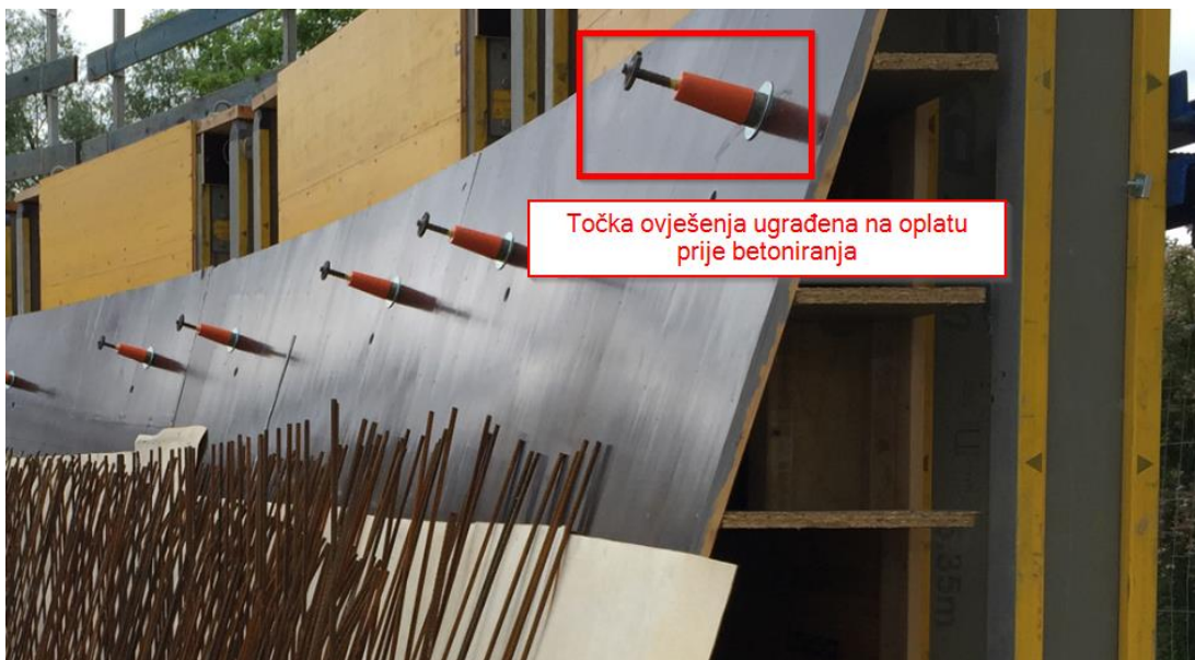
Slika 2.12. Penjajuća oplata i točka ovješnja
