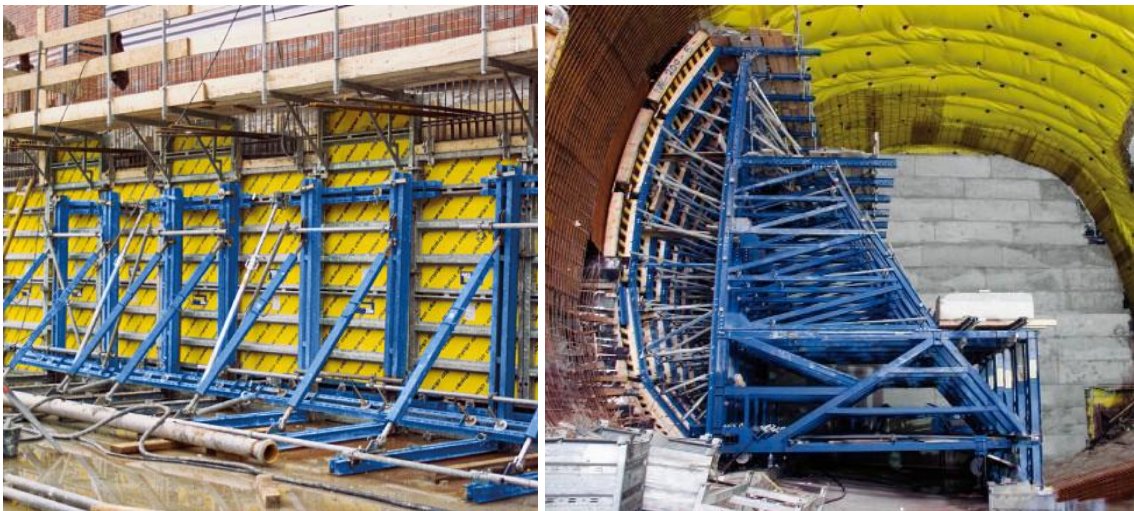
Slika 2.4. Podupirači jednostrane oplata
