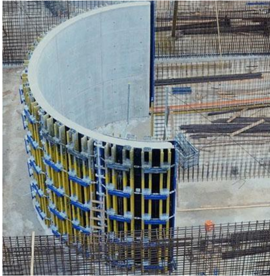
Slika 2.3. Kružna oplata H20
