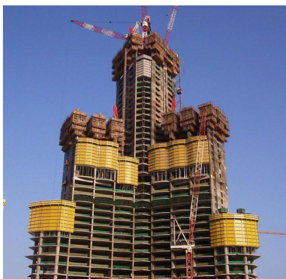
Slika 2.14. Penjajuća oplata SKE50 i SKE100
