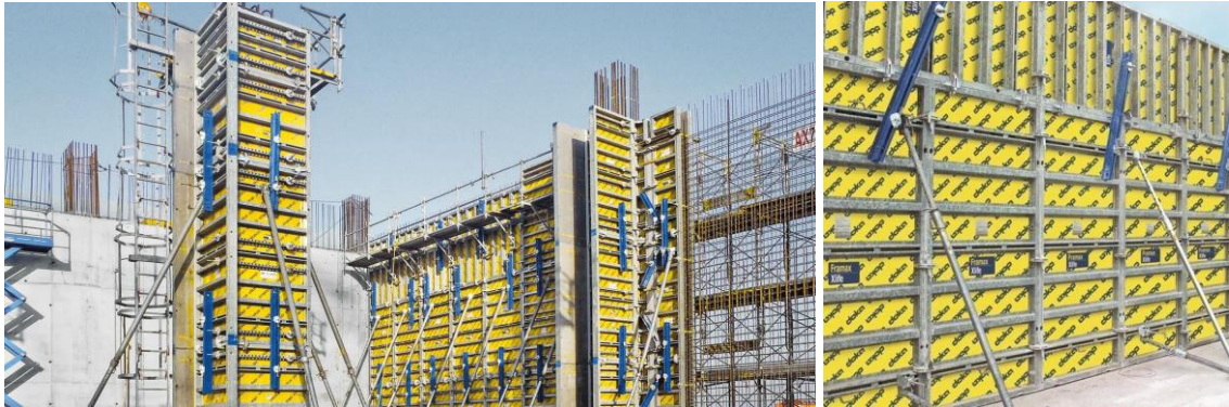
Slika 2.1. Zidna oplata Framax Xlife
