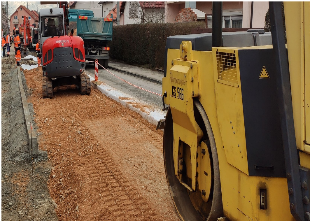
Slika 4.7 Nosivi sloj MNS (vlastiti izvor)
