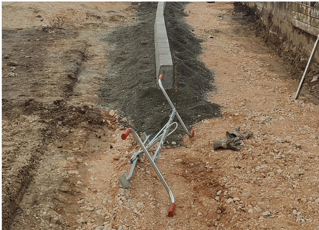
Slika 4.4 Postavljanje betonskih rubnjaka (vlastiti izvor)
