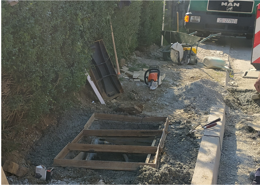
Slika 4.3 Zamjena komunalnog poklopca (vlastiti izvor)
