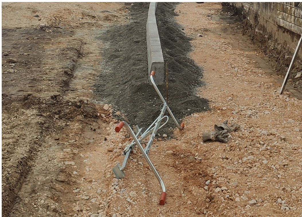
Slika 4.4 Postavljanje betonskih rubnjaka (vlastiti izvor)
