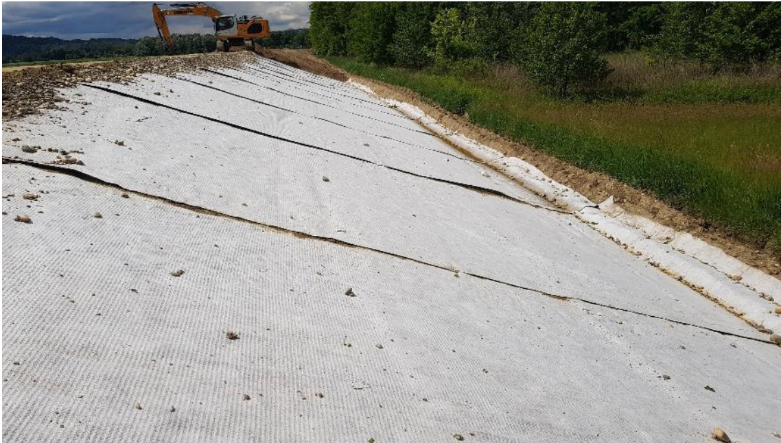
Slika 4.3. Ugradnja geokompozita – Bentonitni tepih Modulo Geobent XP 5/310 – razdjelno / brtveni sloj
