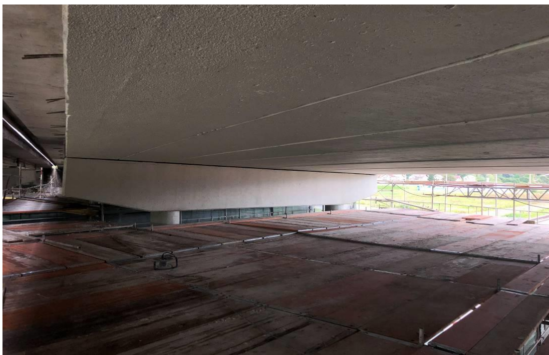
Slika 82. Podgled nadvožnjaka nakon ugradnje sanacijskih materija i trajnoelastičnog zaštitnog sustava
