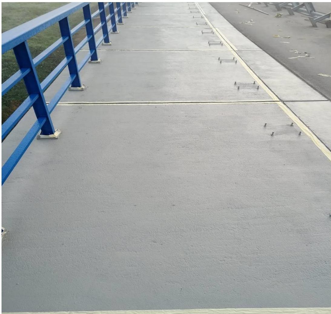
Slika 36. Trajnoelastični poliuretanski sustav na nadvožnjaku Začretje
