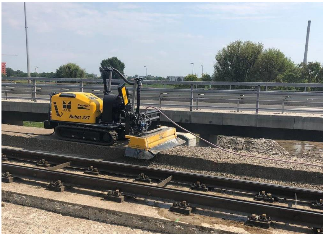
Slika 23. Hidrodemoliranje hodnika tramvajskog mosta Mladost robotiziranim uređajem
