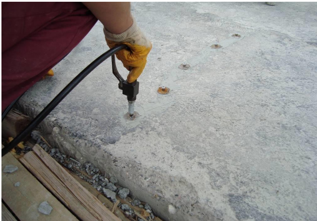
Slika 32. Injektiranje kolničke ploče mosta lijepljenim pakerima
