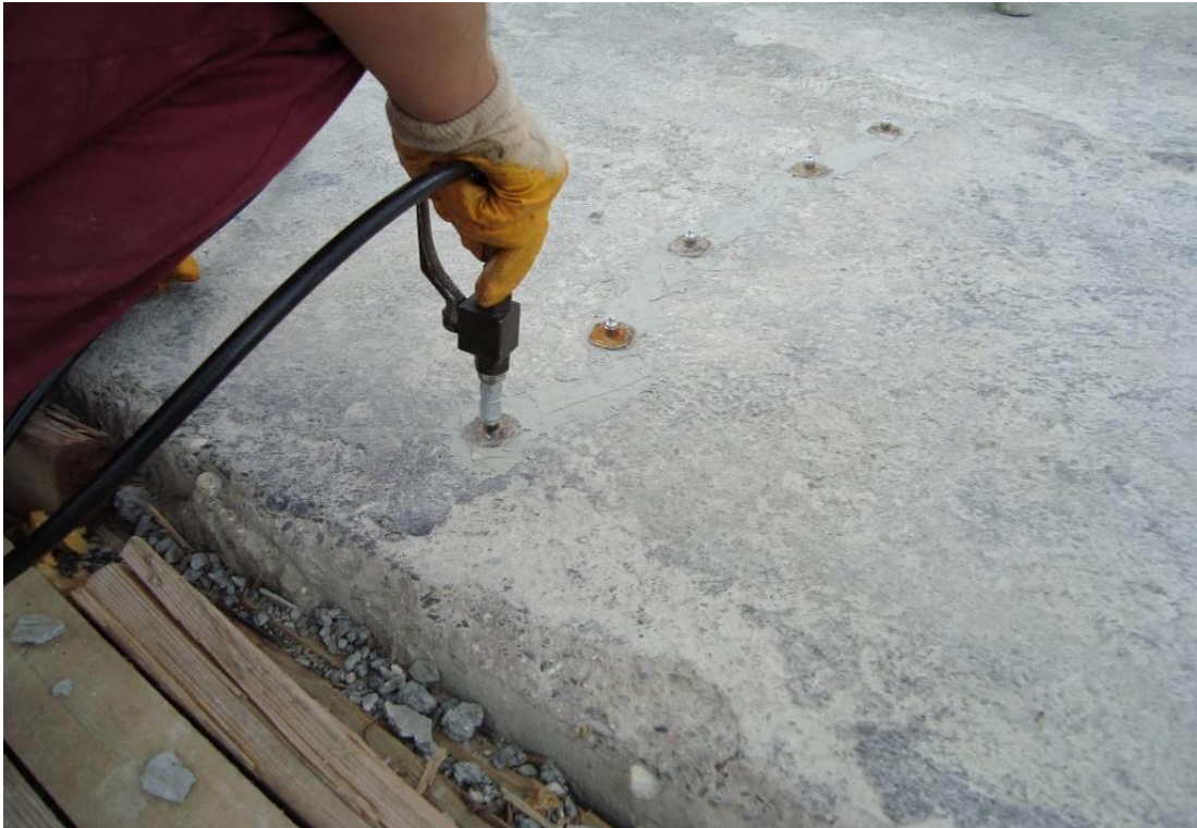
Slika 32. Injektiranje kolničke ploče mosta lijepljenim pakerima
