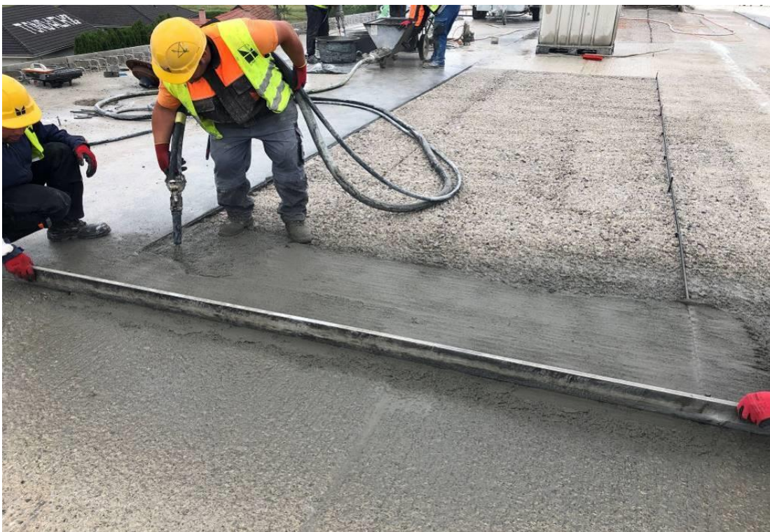
Slika 27. Reprofilacija kolničke ploče nadvožnjaka Zabok reparaturnim mortom
