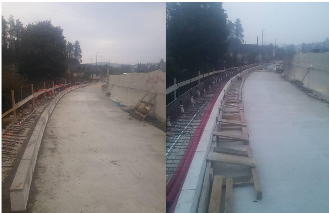
Slika 51. Ugradnja granitnih rubnjaka i priprema za betoniranje hodnika
