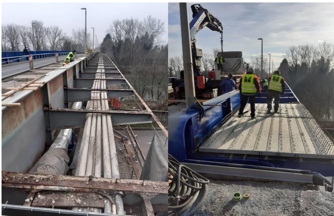
Slika 67. Izgled konzola nakon uklanjanja i montaža novih omnia ploča
