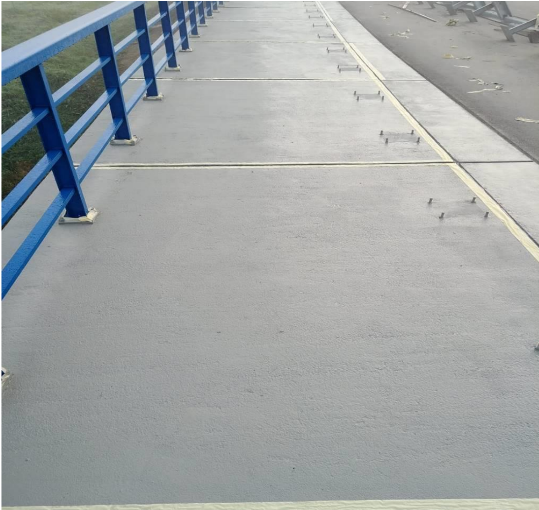
Slika 36. Trajnoelastični poliuretanski sustav na nadvožnjaku Začretje
