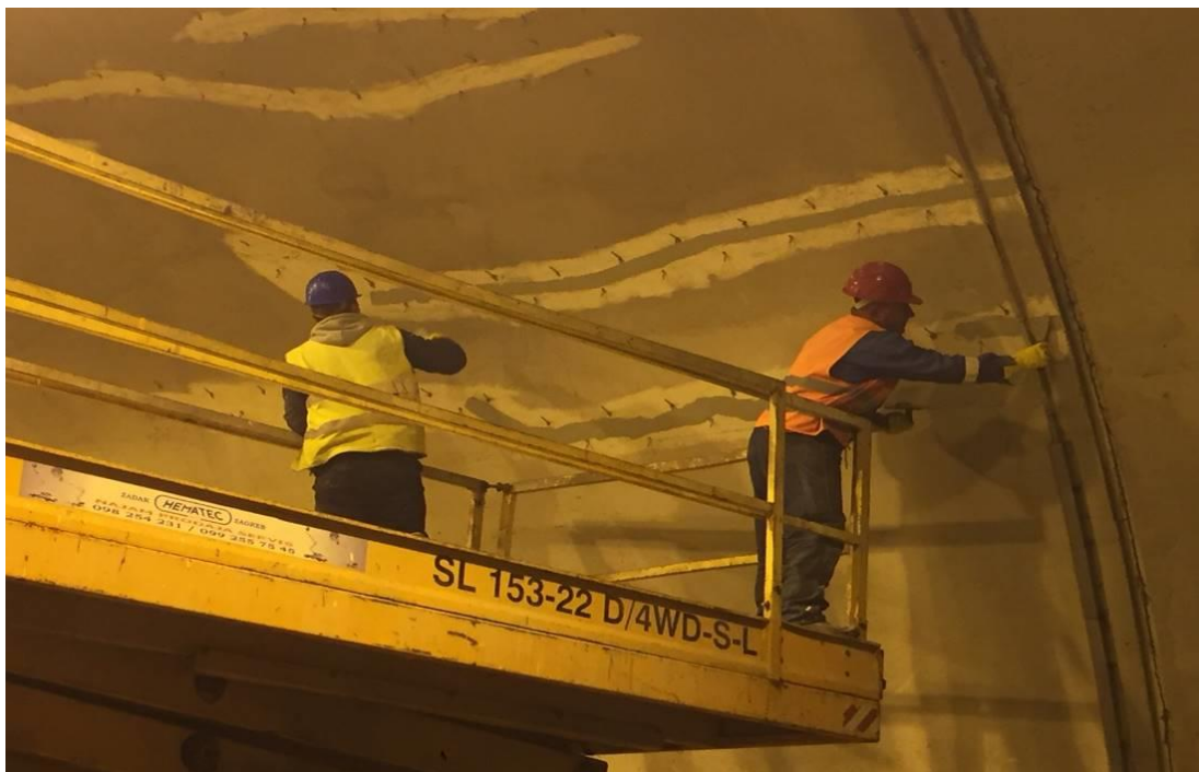
Slika 57. Postavljanje pakera i brtvljenje traga pukotine
