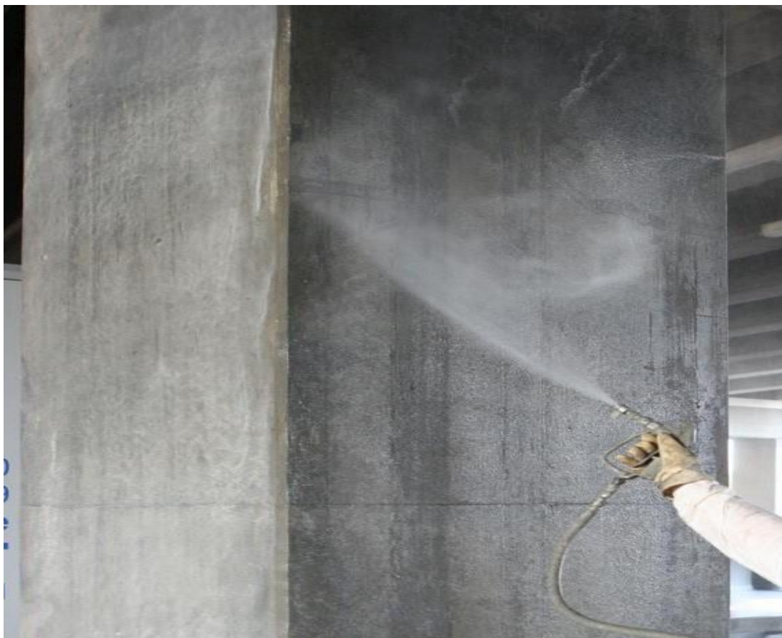
Slika 37. Primjena hidrofobne impregnacije na stupašte nadvožnjaka
