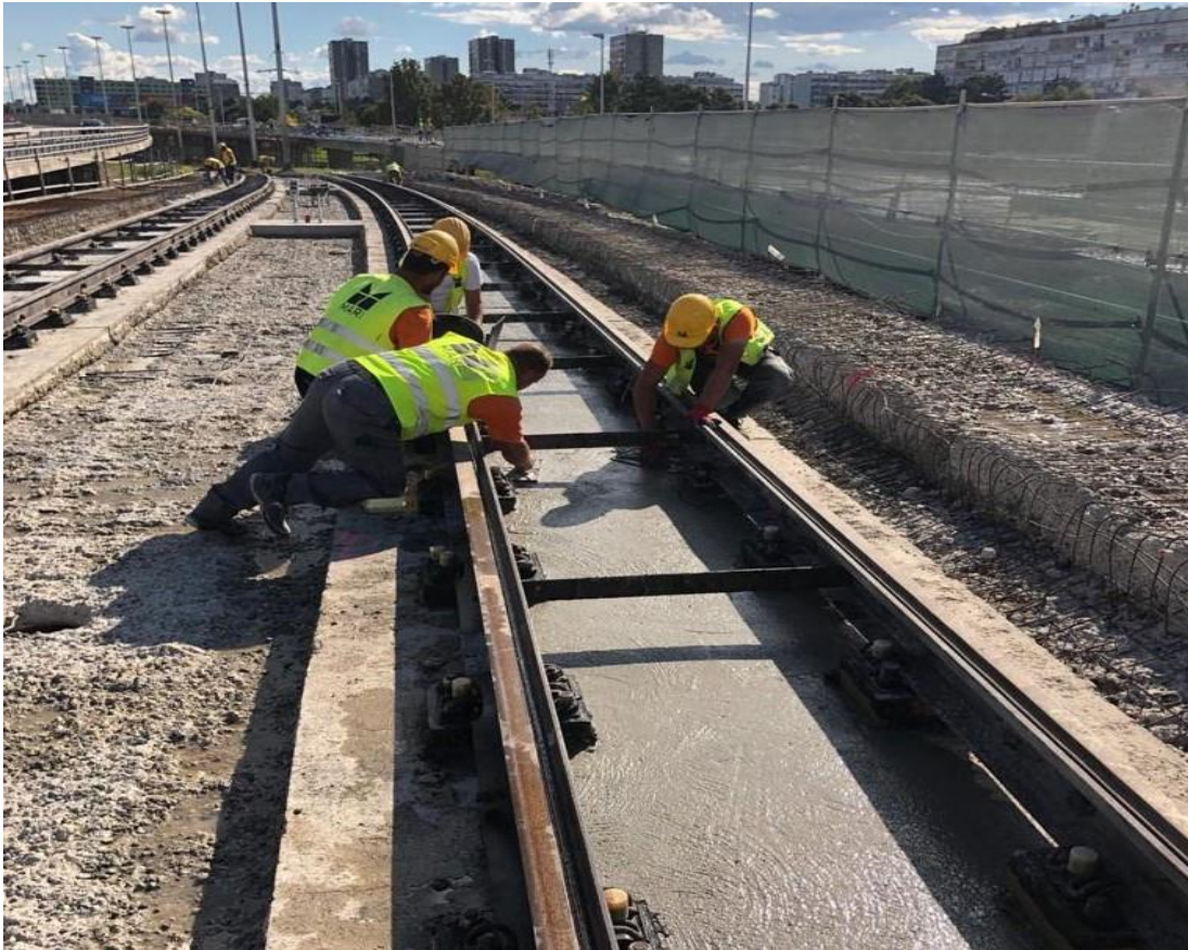
Slika 28. Reprofilacija kolničke ploče tramvajskog mosta Mladost ugradnjom betona
