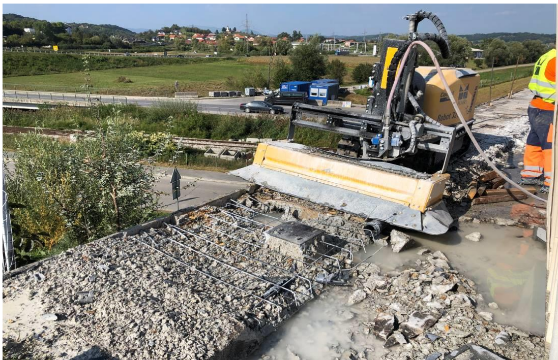
Slika 75. Hidrodinamičko uklanjanje betona nadvožnjaka robotiziranim uređajem s automatskim navođenjem
