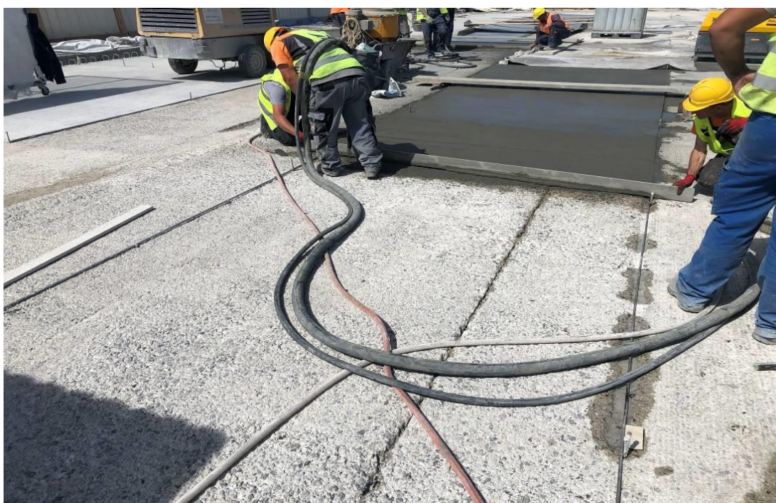
Slika 76. Reprofilacija kolničke ploče nakon uklanjanja oštećenog betona
