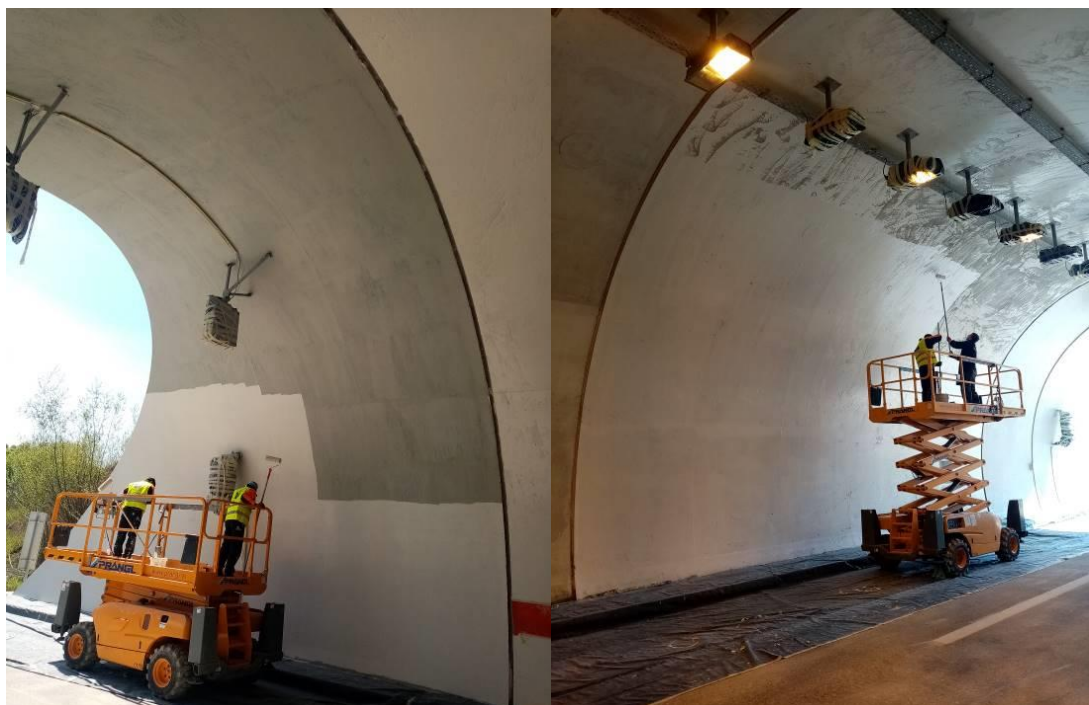
Slika 60. Nanošenje završnog zaštitnog sustava
