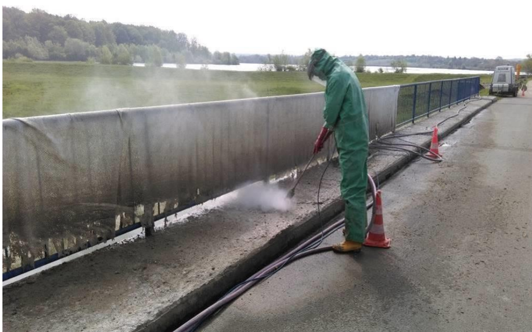
Slika 24. Hidrodemoliranje hodnika mosta Siščani
