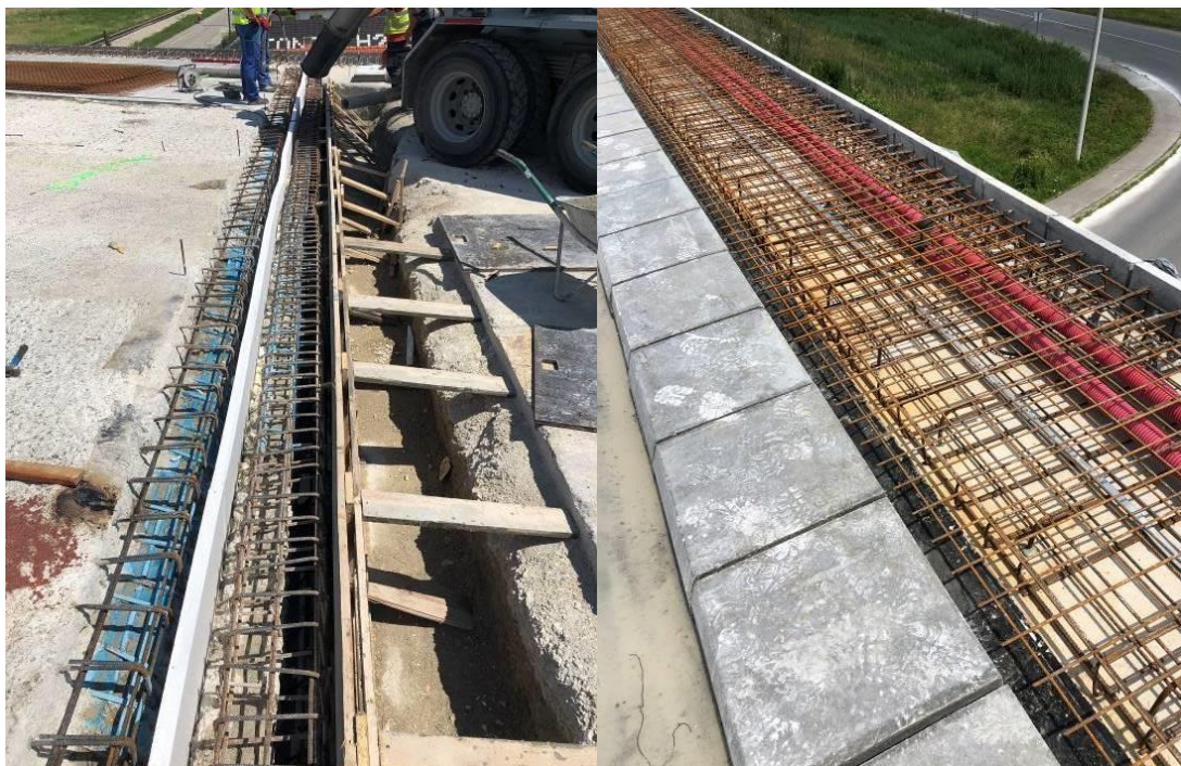
Slika 77. Ugradnja oplata, armature i betona za izradu novih hodnika i greda novih prijelaznih naprava
