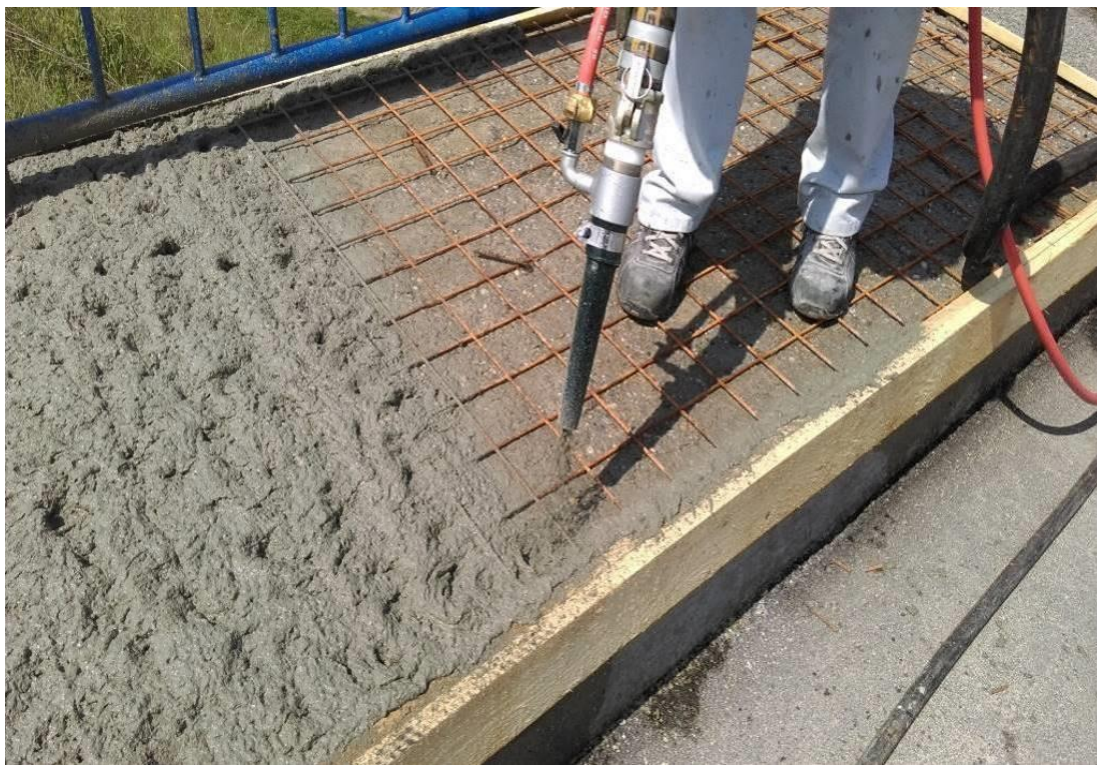
Slika 26. Reprofilacija hodnika mosta Siščani reparaturnim mortom
