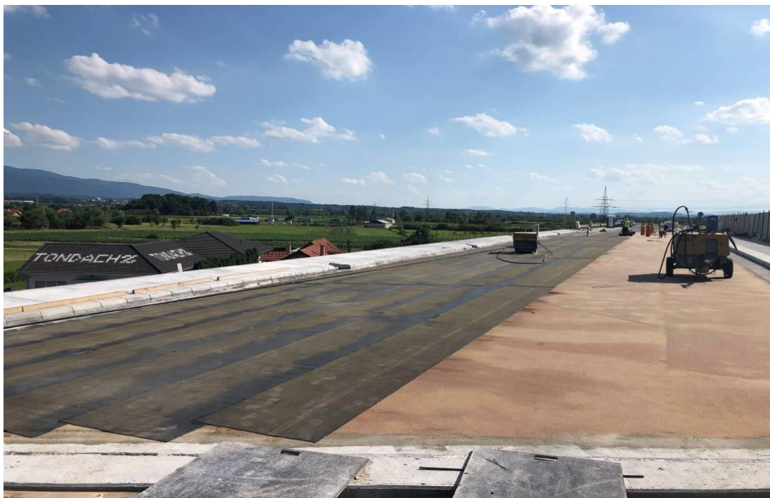
Slika 81. Ugradnja hidroizolacijskog sustava od varenih mosnih bitumenskih elastomernih traka debljine 5 mm
