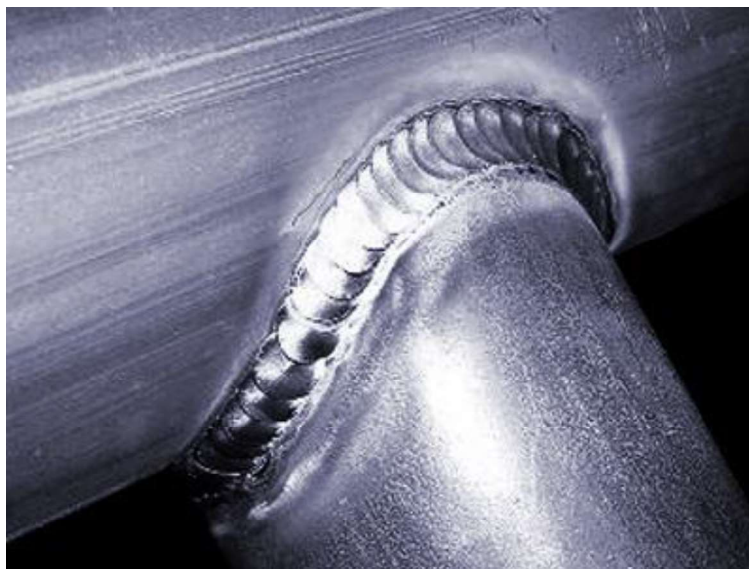
Slika 18. Zavar cijevi TIG metodom zavarivanja [21]
