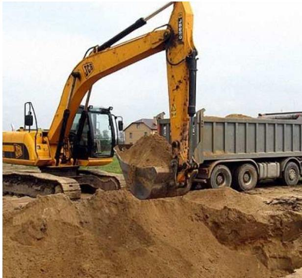
Slika 3.1.1. Strojni iskop zemljanog materijala
