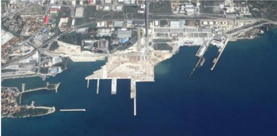
Slika 9 Luka Gaženica u vrijeme izgradnje 2014. godine
