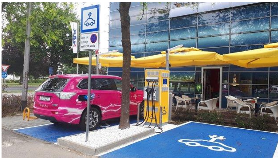
Slika 3 prikazuje punionicu za električna vozila
