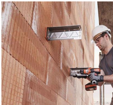
Slika 6.2.2. Postavljanje nosača
