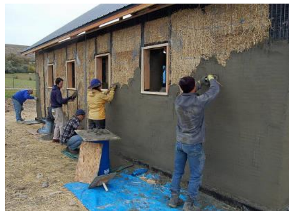
Slika 1.3. Blokovi bala u drvenoj konstrukciji Slika 1.4. Žbukanje slame
