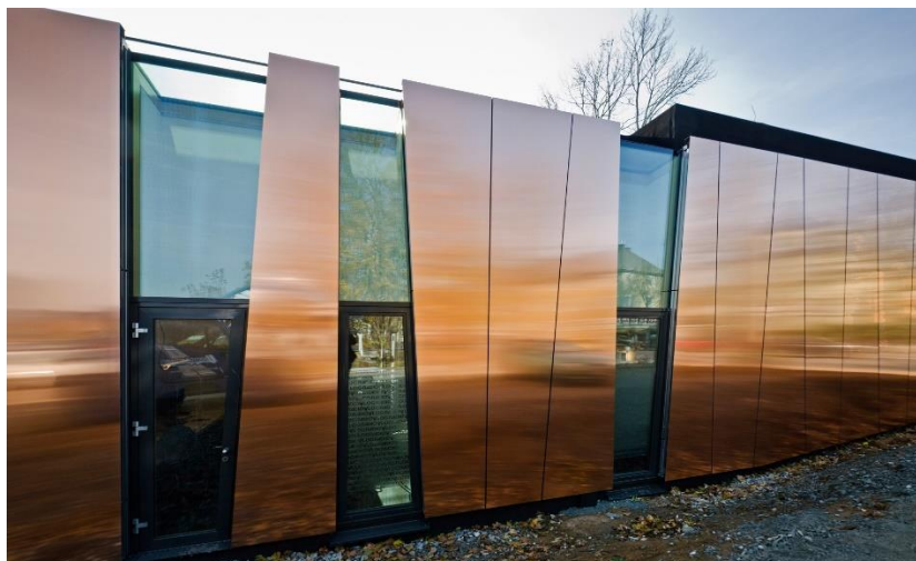
Slika 6.2.6. Primjer ventiliranog fasadnog sustava
