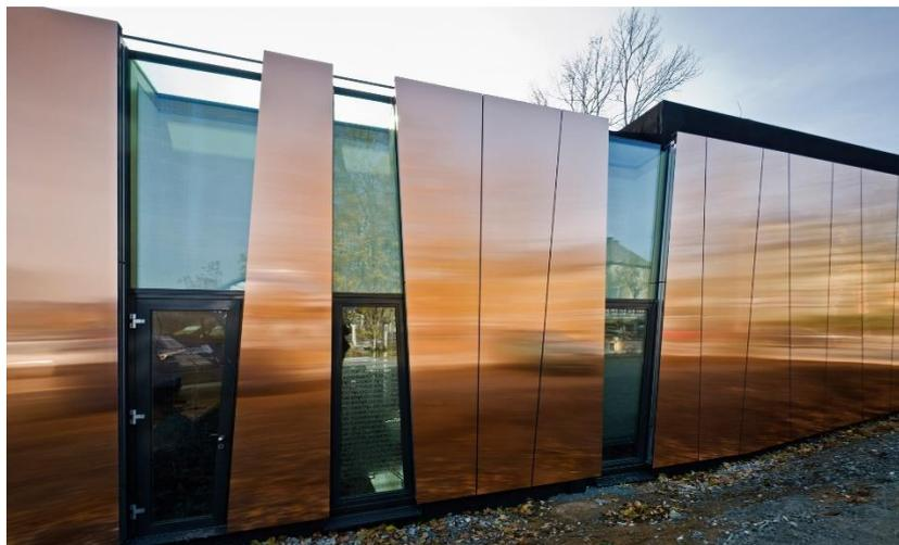
**Slika 6.2.6.** Primjer ventiliranog fasadnog sustava
