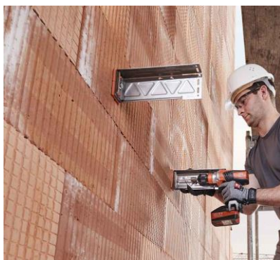
Slika 6.2.2. Postavljanje nosača
