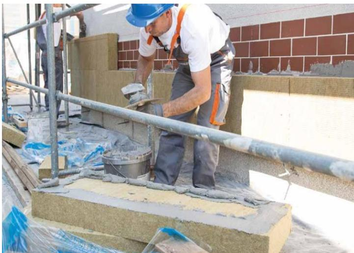
**Slika 4.1.1.** Izoliranje zida kamenom vunom
