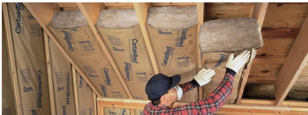
Slika 4.1.3. Oblaganje krovišta staklenom vunom
