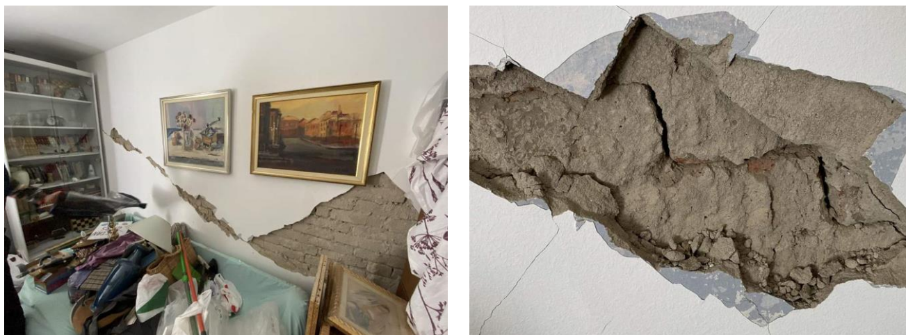
Slika 4.15. Unutarnji pregradni zid prizemlja etaže 2;
