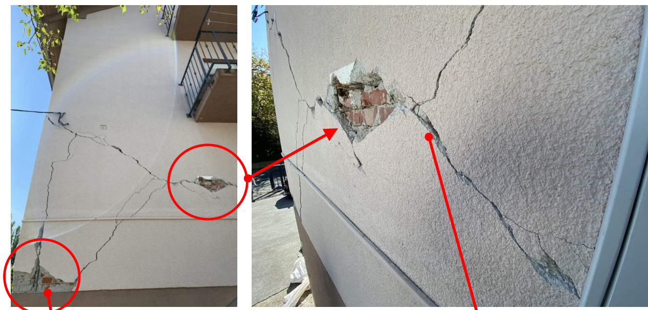
Slika 4.4. Konstruktivni istočni vanjski nosivi zid;
