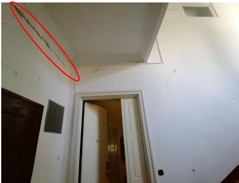
Slika 4.39. Već karakteristične horizontalne pukotine na spojevima zidova i stropova
