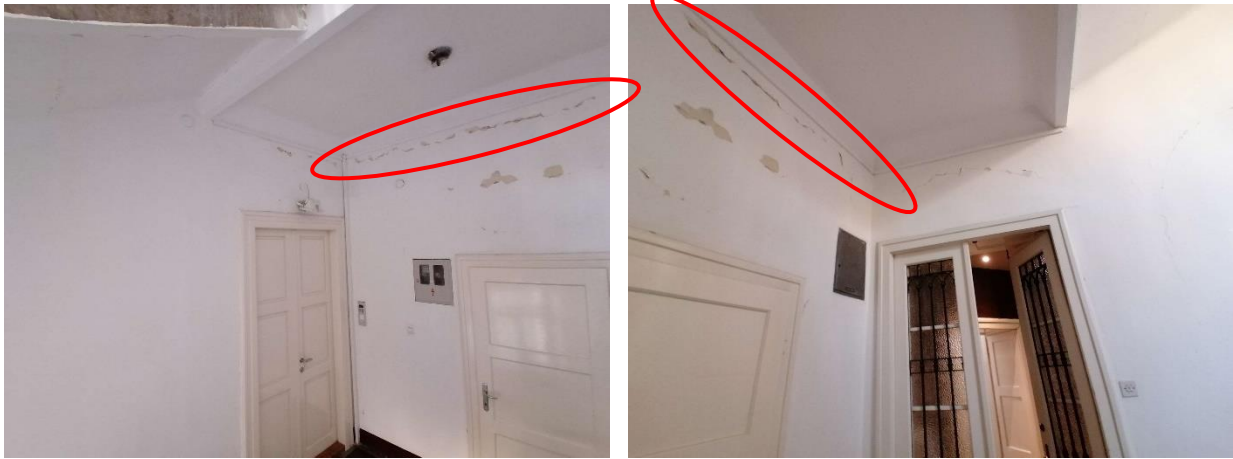
Slika 4.40. Horizontalne pukotina na mjestima spoja čeličnih nosača stubišnog podesta
