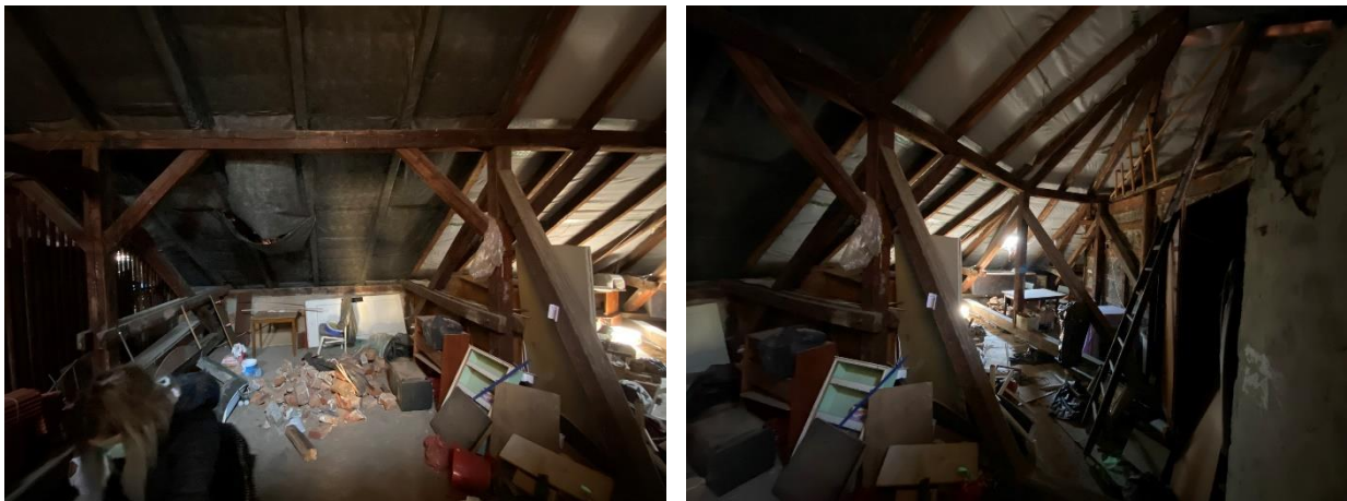
Slika 4.25. Pogled sa ulaza na krovište (lijevo) te pogled prema ulazu (desno)
