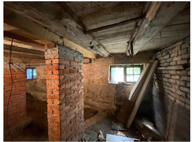
Slika 3.15. Prikaz stropne konstrukcije u podrumu
