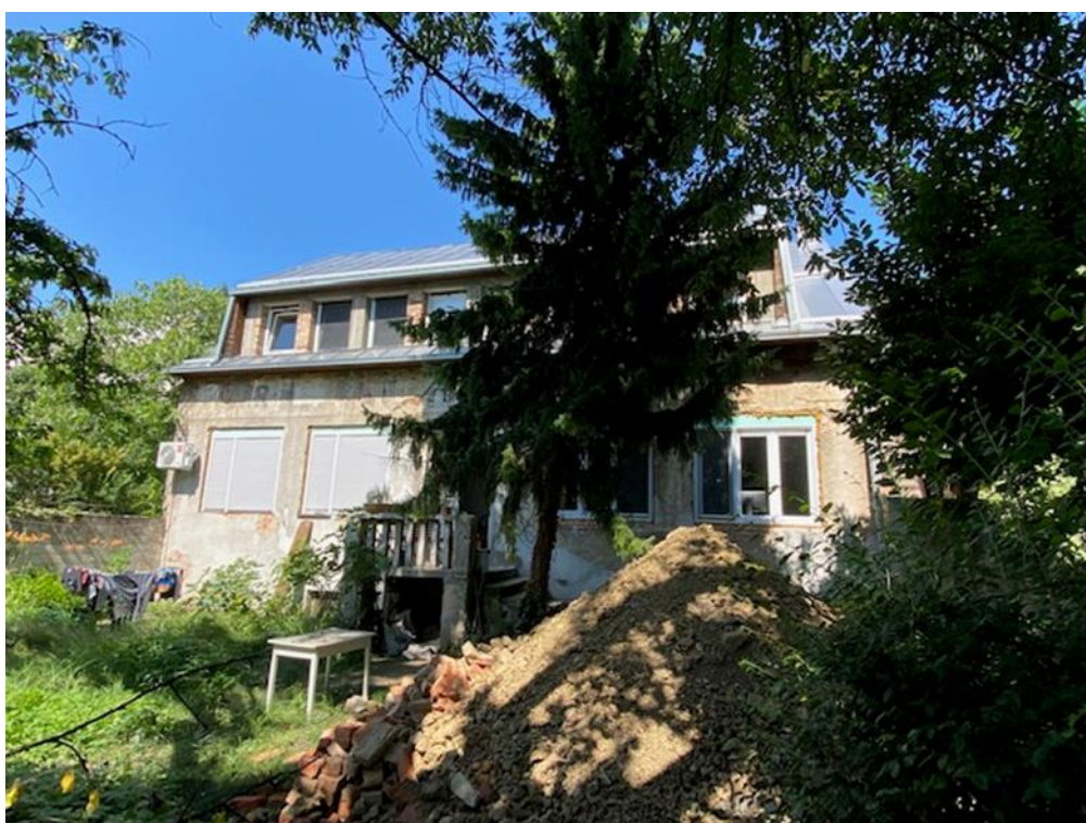
Slika 3.11. Pogled na zapadno pročelje predmetne zgrade
