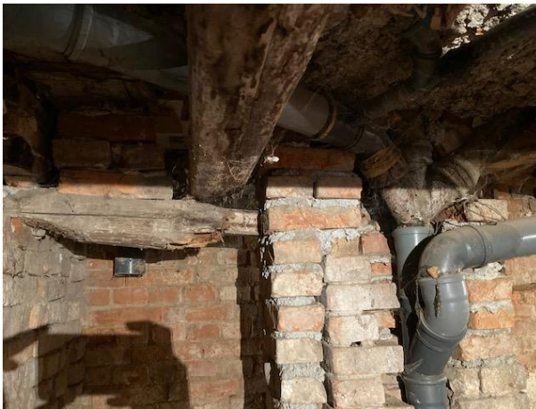
Slika 3.12. Prikaz stropne konstrukcije u podrumu
