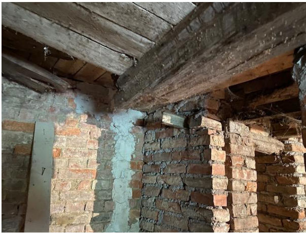
Slika 3.14. Prikaz stropne konstrukcije u podrumu
