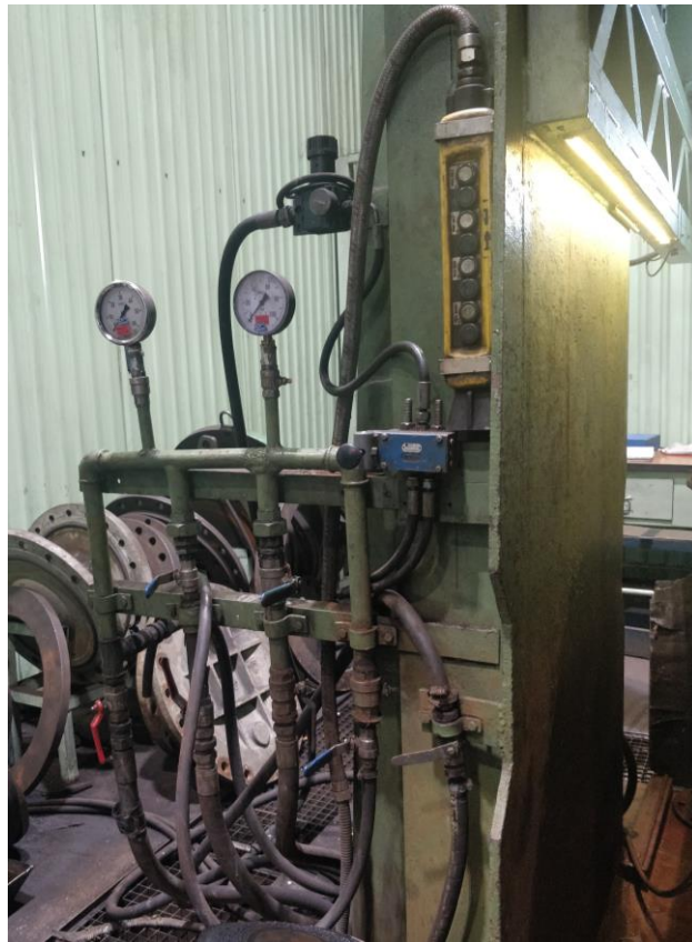
Slika 17. Oprema za mjerenje
