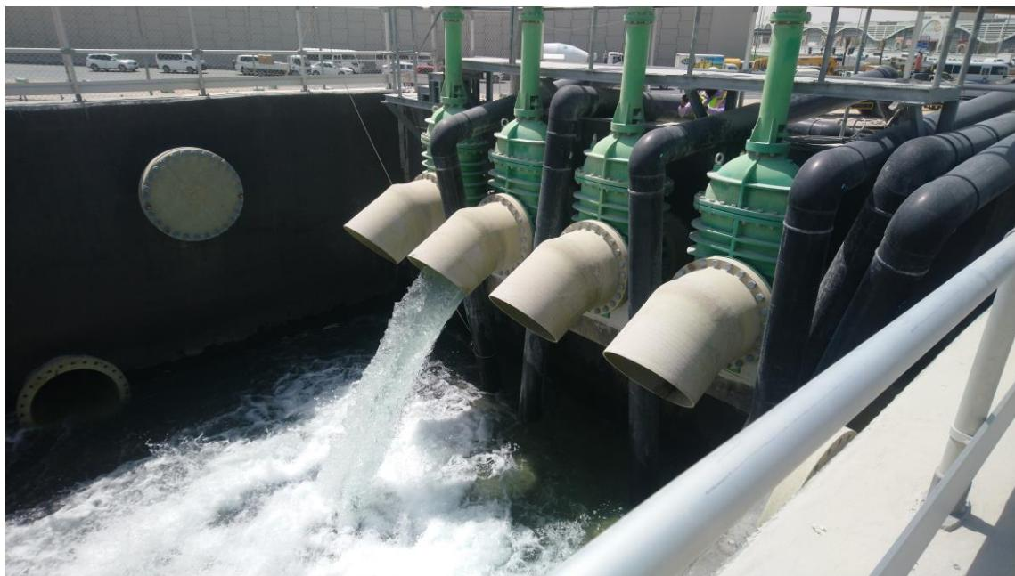
*Slika 11. Ovalni zasuni ugrađeni u Kataru, Doha (New Orbital Highway)*
