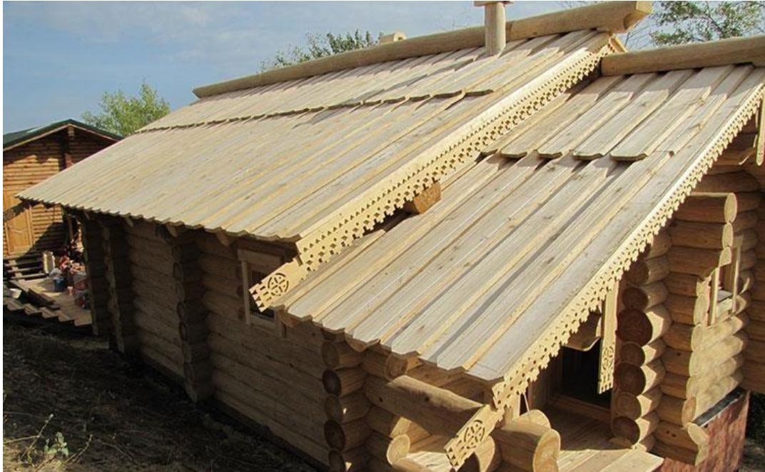
Slika 3.2 Pokrov krova daskama okomito na strehu
