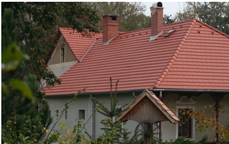
Slika 3.15 Pokrov od betonskog biber crijepa
