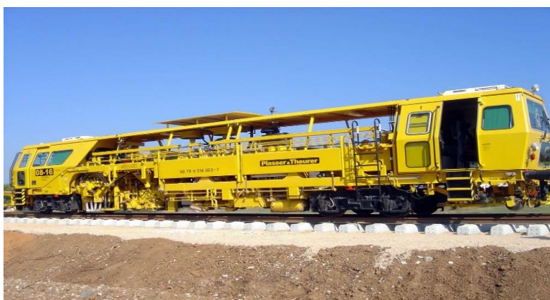
Slika 47. Strojni radovi na obnovi (remontu)
