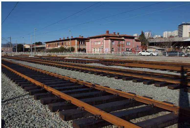
Slika 41. Željeznički kolosijek na drvenim pragovima
