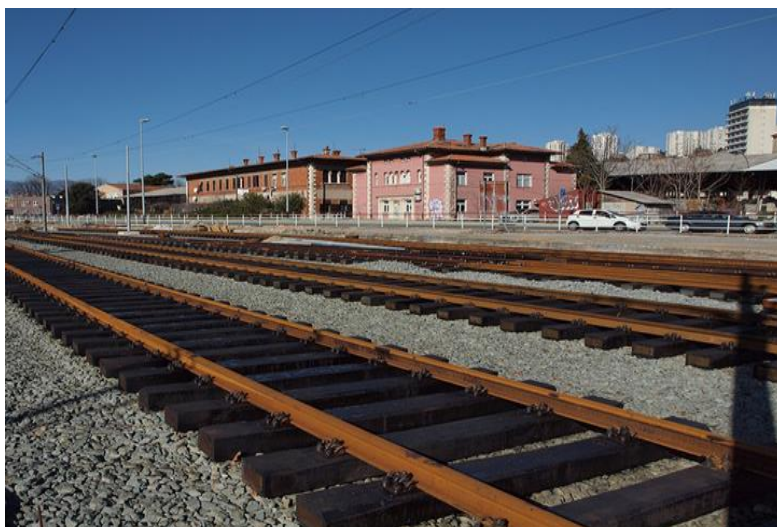
Slika 41. Željeznički kolosijek na drvenim pragovima
