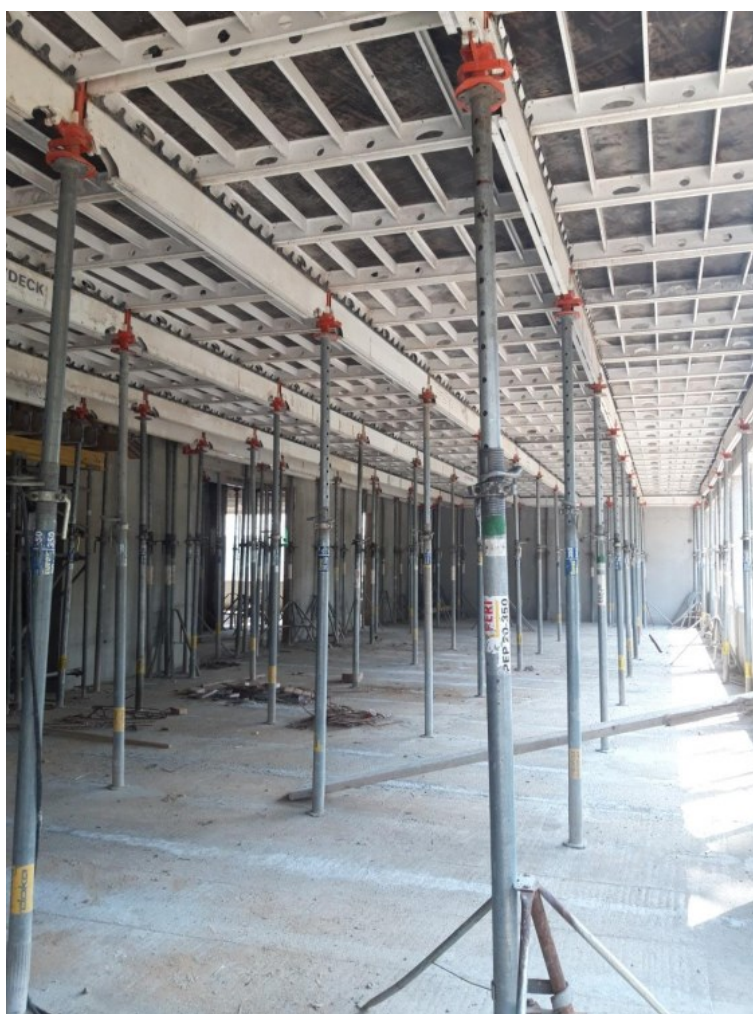
Slika 8: Prikaz postavljene oplata i podupirača
