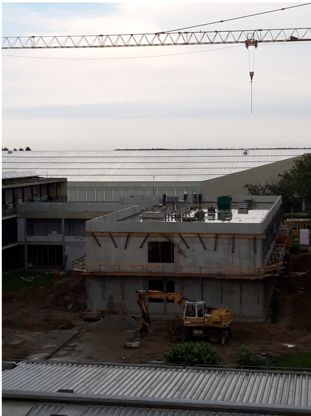
Slika 7: Završeni armirači i betonski radovi na objektu
