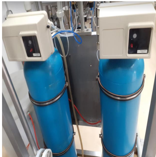
Slika 3.7. Ionski izmjenjivači (vlastiti izvor)
