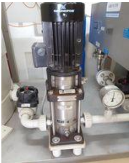
Slika 3.4. Cirkulacijska pumpa (vlastiti izvor)
