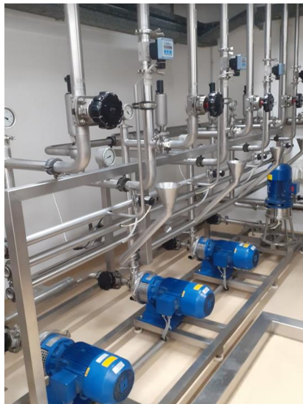
Slika 3.19. Distribucijske pumpe i distribucijske petlje (vlastiti izvor)
