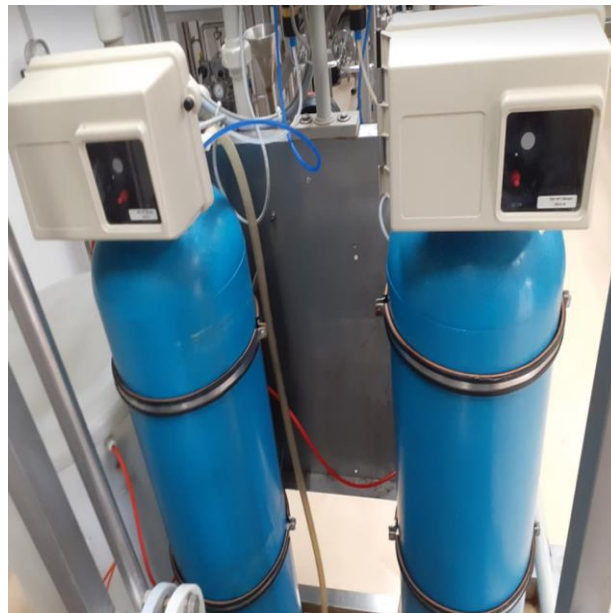
Slika 3.7. Ionski izmjenjivači (vlastiti izvor)
