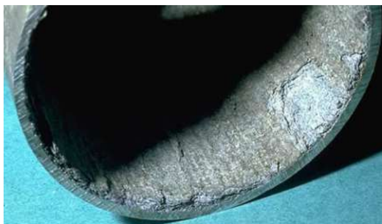
Slika 4 - Primjer selektivne korozije
