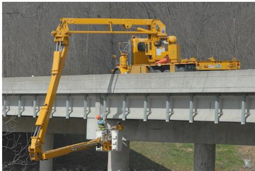
Slika 9. Glavni pregled mosta uporabom specijalnog vozila
