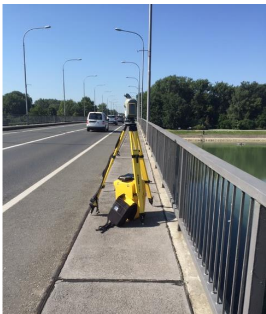
Slika 31. Skeniranje cestovnog mosta
