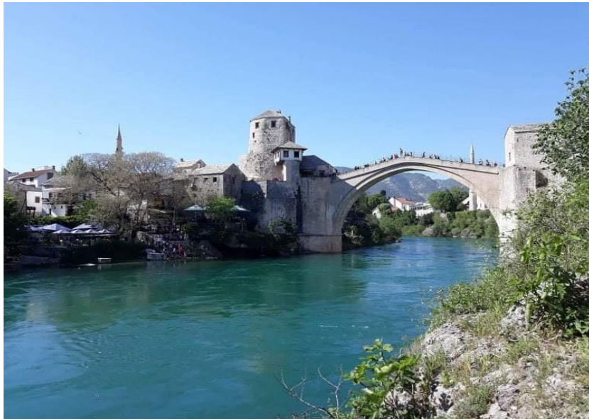
Slika 6. Obnovljeni kameni most u Mostaru
