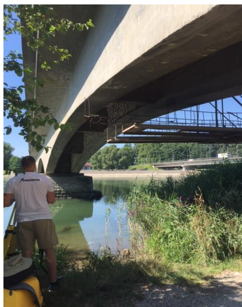
Slika 32. Skeniranje željezničkog mosta
