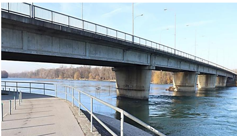
Slika 30. Most bana Josipa Jelačića
