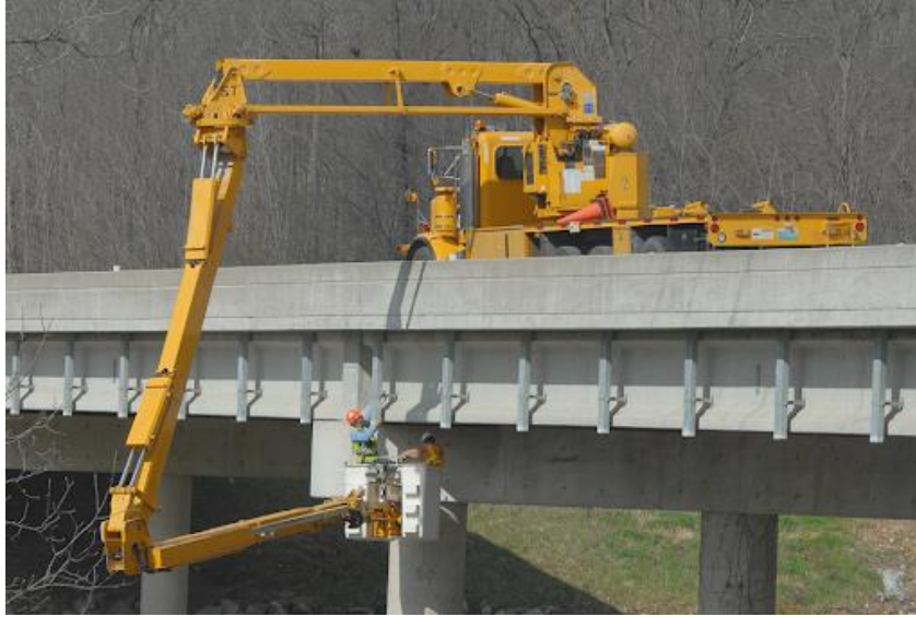
Slika 9. Glavni pregled mosta uporabom specijalnog vozila
