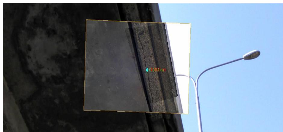
Slika 38. Oštećenje nastalo pod utjecajem vlage
