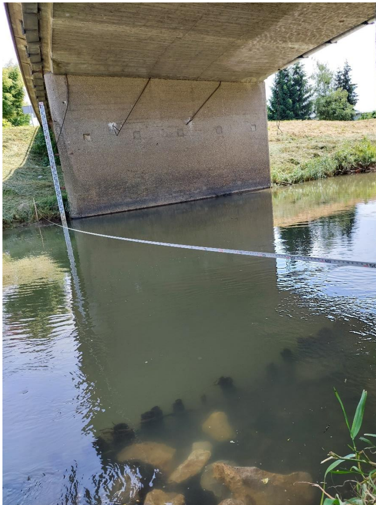
Slika 3.16. Postavljanje mjerne trake
