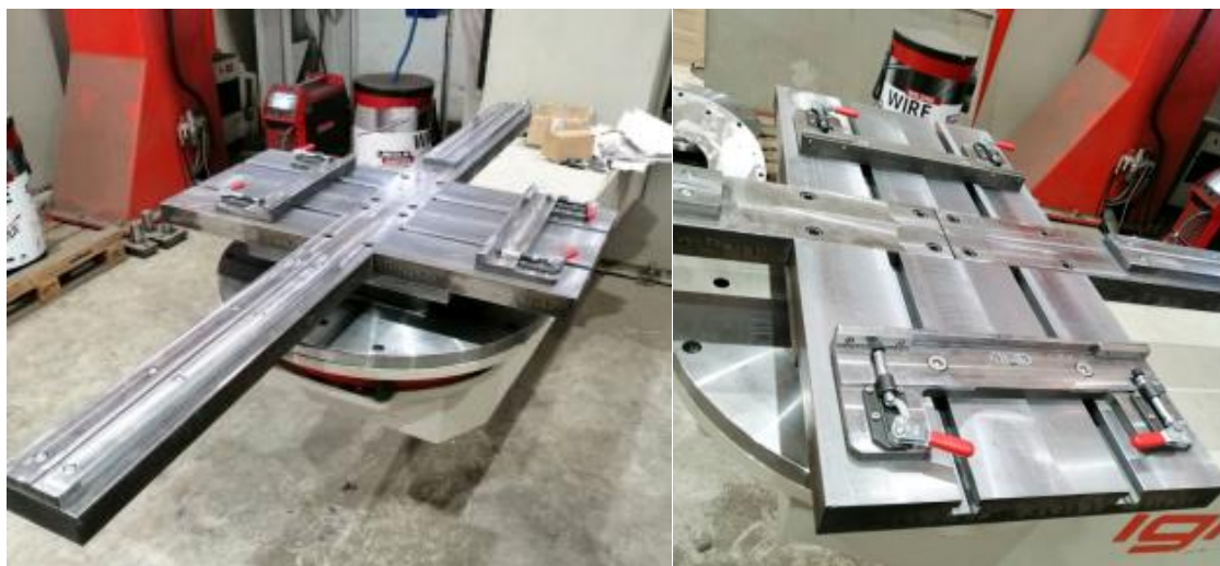
Slika 50. Naprava za robotsko zavarivanje dna transformatorskog kotla
