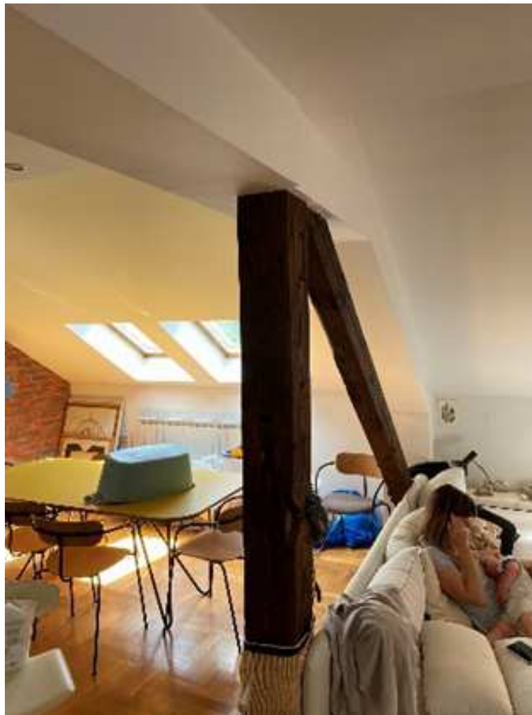
Slika 37. Krovna konstrukcija u potkrovlju stambene zgrade
