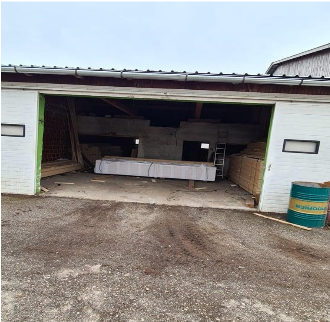
Slika 5. 20 Skladište za gotove proizvode
