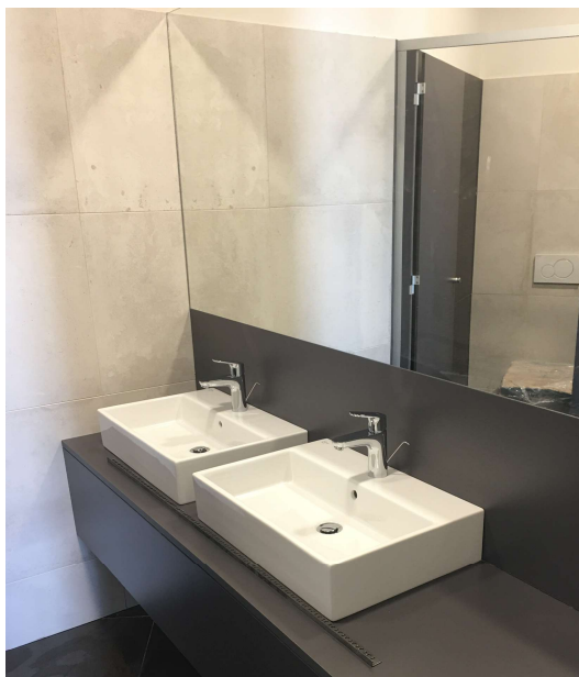
Slika 5.8 Zidovi u sanitarnim čvorovima
