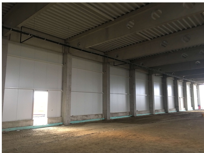
Slika 5.6 Vanjski zidovi od montažnih lakih sendvič panela
