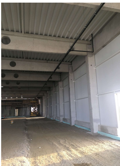
Slika 5.4 Skeletna montažna konstrukcija
