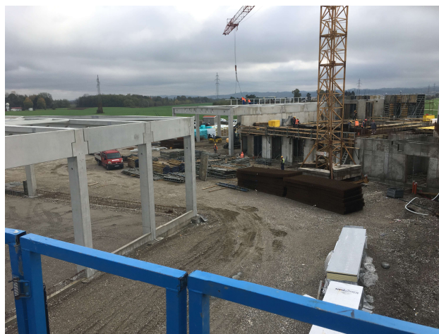
Slika 5.3 Prijenos tereta auto - dizalicom
