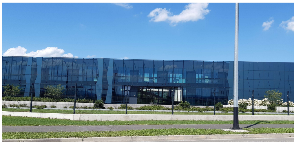
Slika 5.18 Fotonaponski moduli na fasadi
