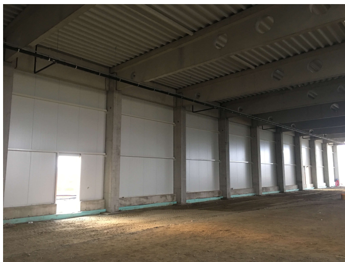
Slika 5.6 Vanjski zidovi od montažnih lakih sendvič panela
