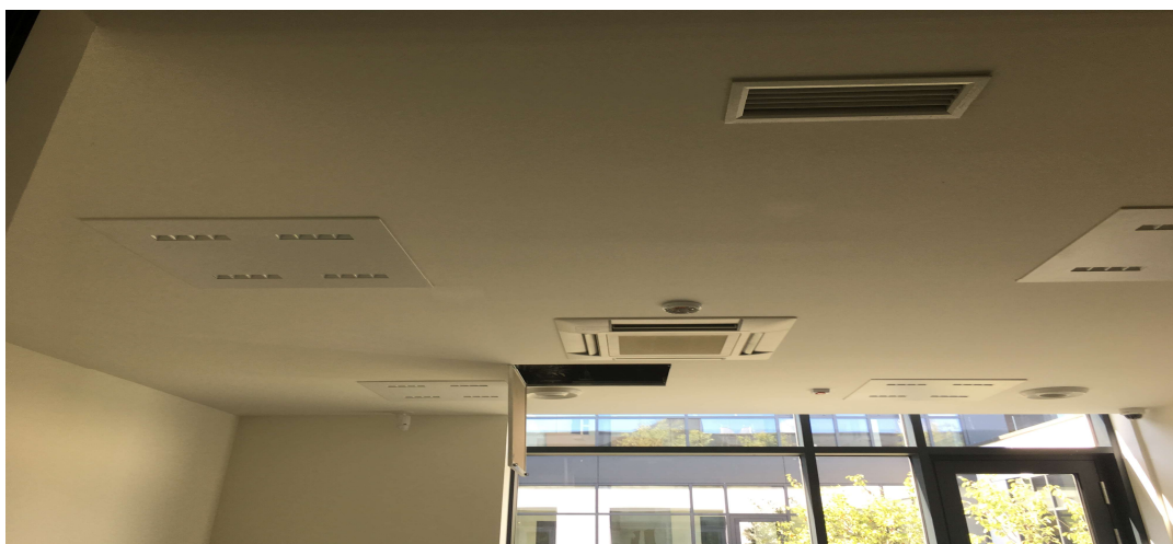
Slika 5.11 Spušteni strop – prizemlje dilatacija B
