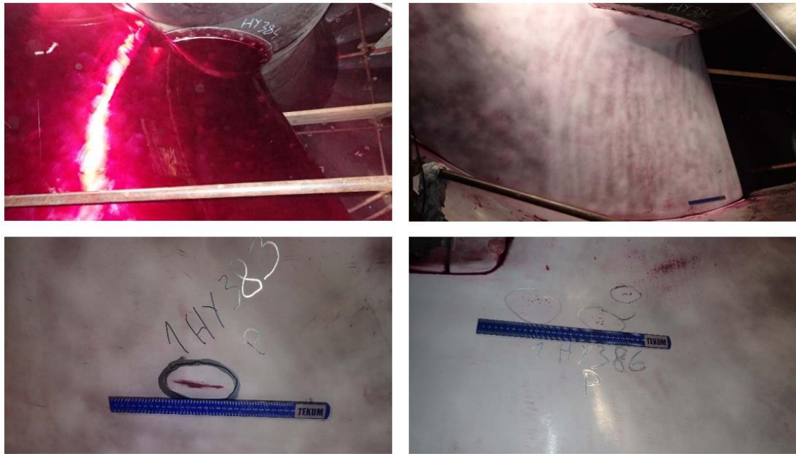
Slika 26. Oštećenja utvrđena penetrantskom metodom
