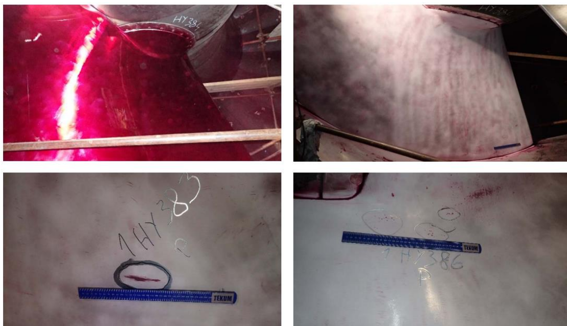
Slika 26. Oštećenja utvrđena penetrantskom metodom
