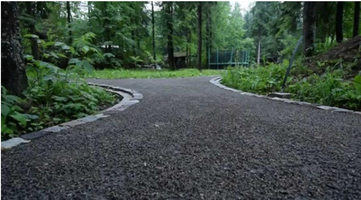
Slika 3.22 Primjer 3.16 Upotreba recikliranog materijala (asfaltne mrvice) u kombinaciji s prirodnim kamenom (kamen - granit). 53
