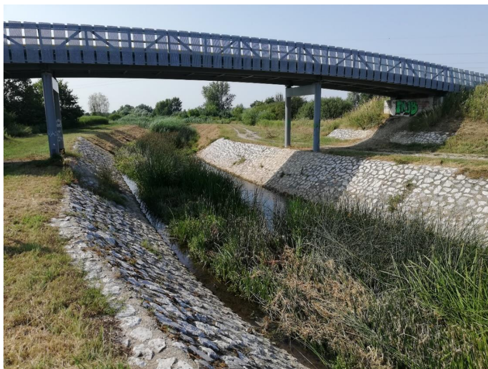
Slika 1.4. Primjer obaloutvrde na rijeci Plitvici kod Varaždina [3]
