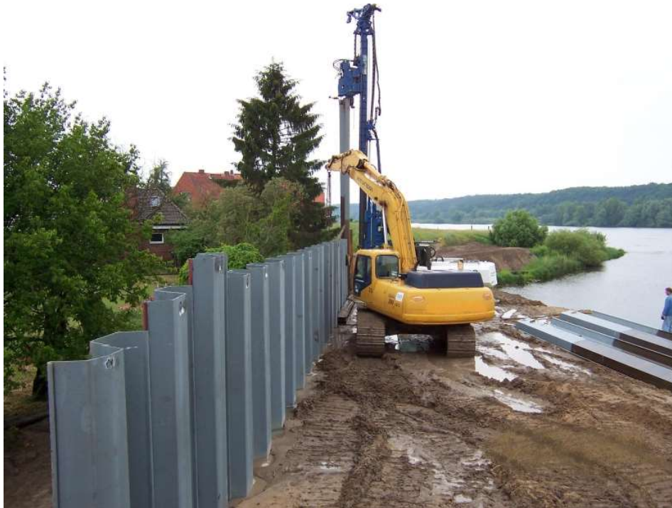
Slika 21 : Postavljanje metalnog žmurja
