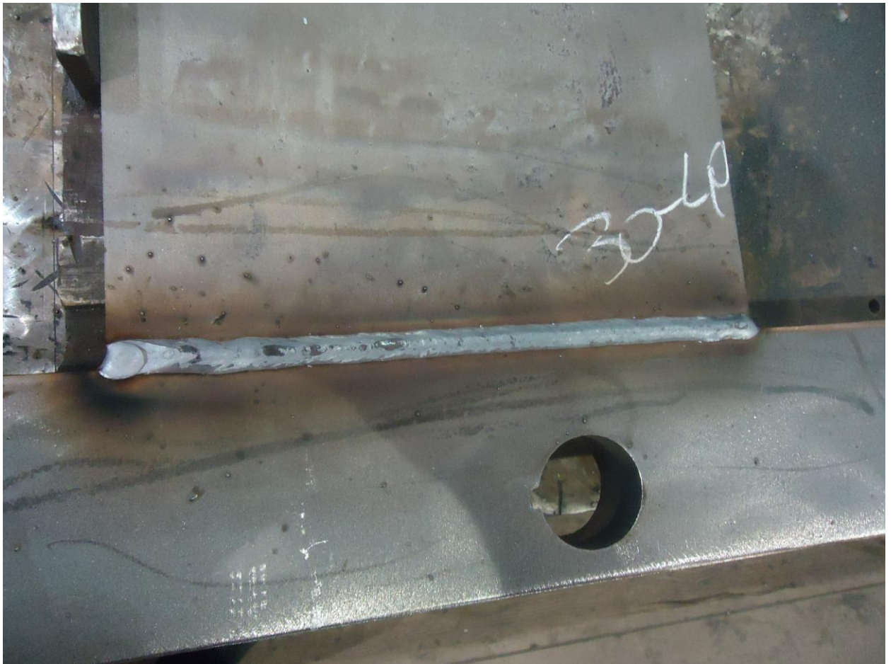
Slika 5.11 Izgled zavara (K-priprema)
