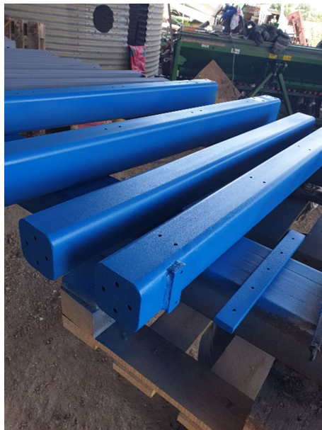
Slika 3.40 Premaz završnim slojem
