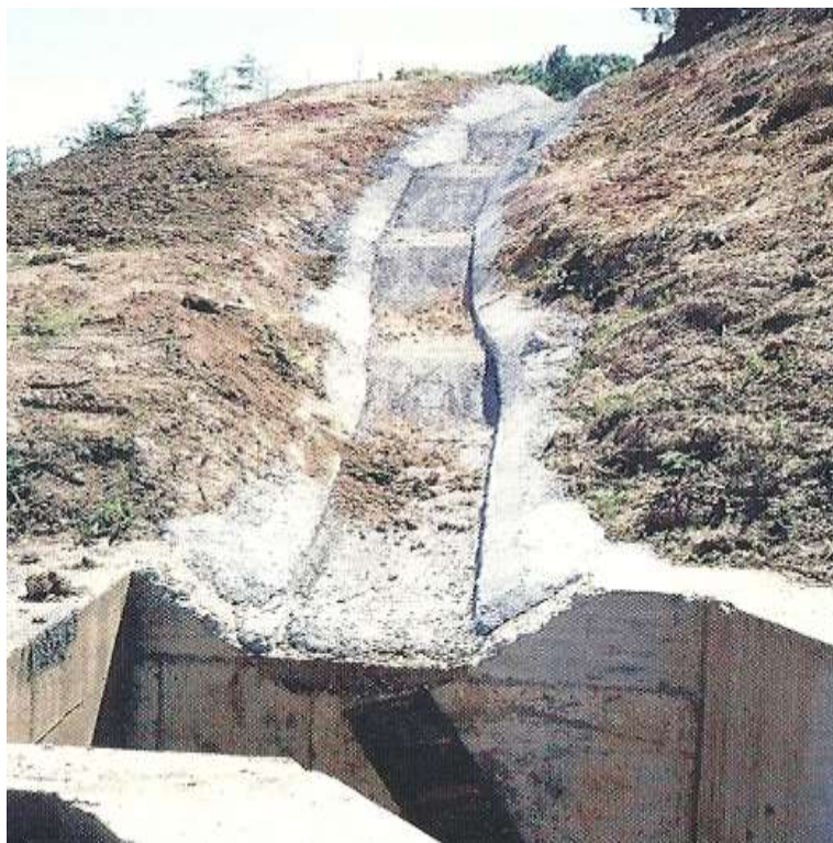
Slika 2.1.7. Kaskadni odvodni jarak
