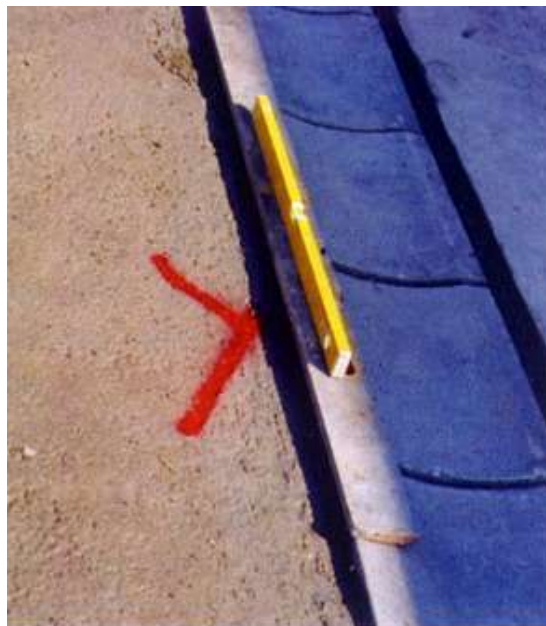
Slika 2.3.2. Postavljanje rigola u praksi
