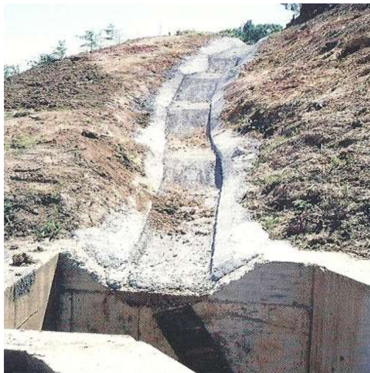
Slika 2.1.7. Kaskadni odvodni jarak
