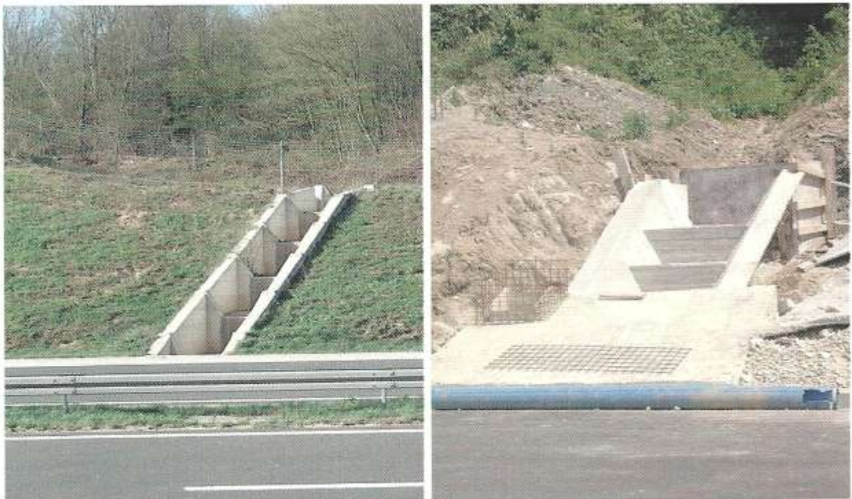
Slika 4.2.2 Kaskade na uljevu u propust
