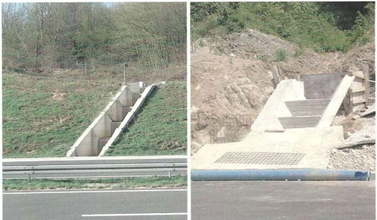
Slika 4.2.2 Kaskade na uljevu u propust
