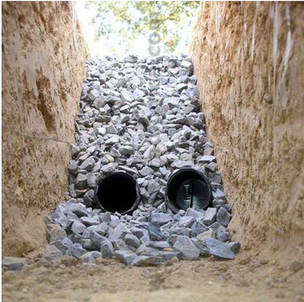
Slika 3.1.1.3 Primjer postavljanja cijevi u praksi
