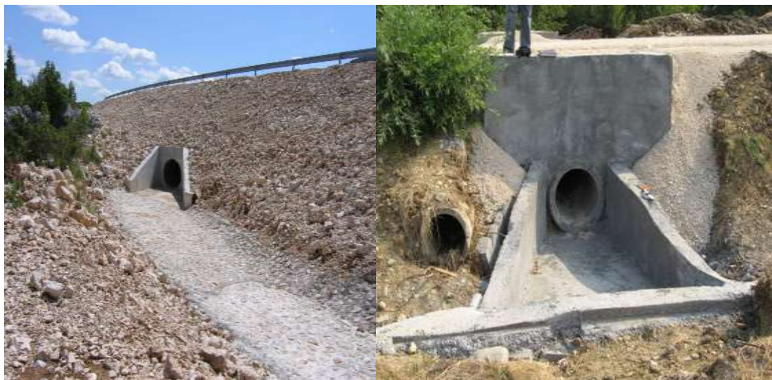
Slika 4.1.1.4 Cijevni propusti u praksi
