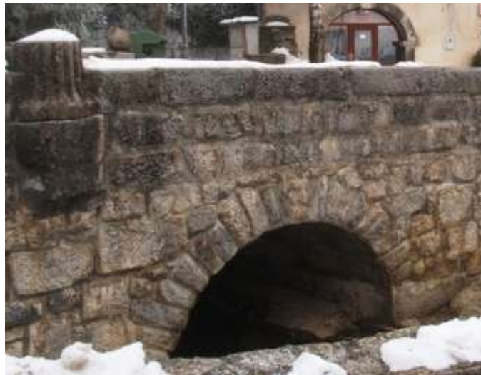
Slika 4.1.2.1 Svođeni propust
