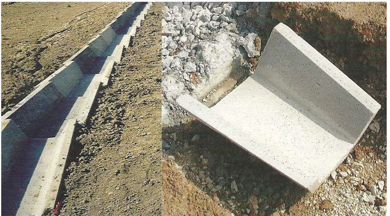
Slika 2.3.8. Detalj predgotovljenog otvorenog kanala
