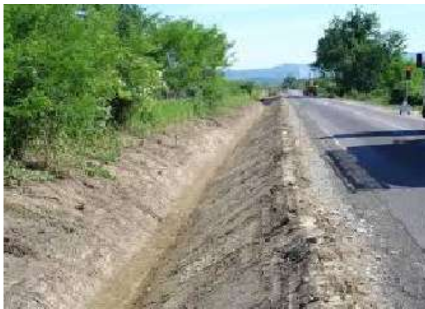
Slika 2.1.3.a) Odvodni jarak (trapezni)
