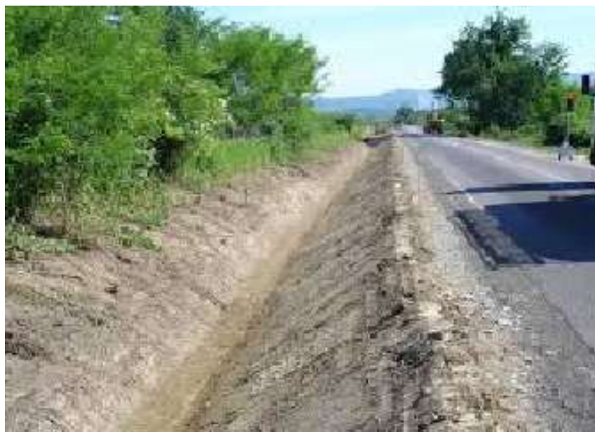
Slika 2.1.3.a) Odvodni jarak (trapezni)
