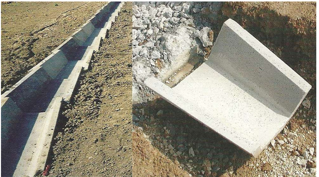
Slika 2.3.8. Detalj predgotovljenog otvorenog kanala
