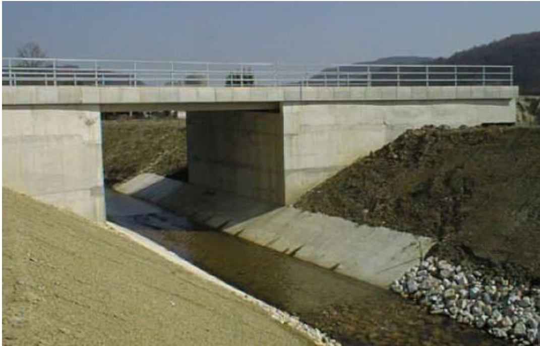
Slika 4.1.3.3. Gotovi pločasti propust u praksi
