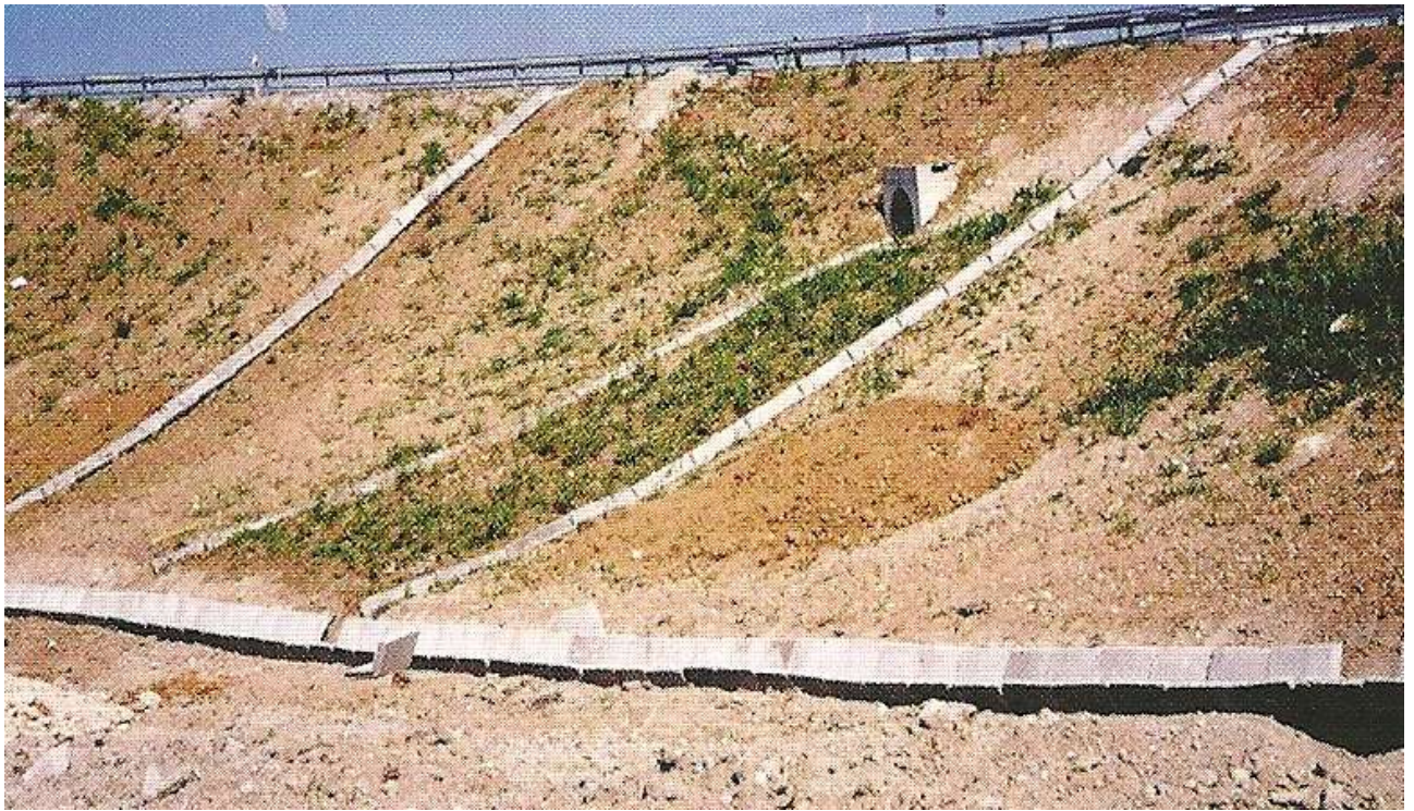
Slika 2.3.7. Otvoreni kanali niz pokos izvedba (u praksi)
