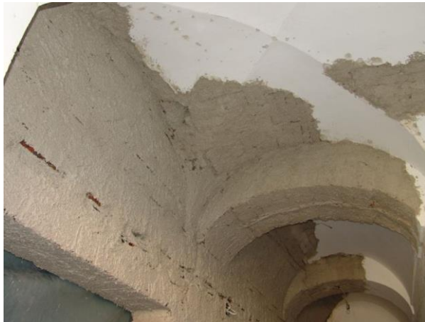
Slika 5.14 Ugradnja karbonskih traka na zidove
