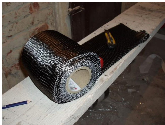
Slika 5.21 Ugrađivana karbonska traka
