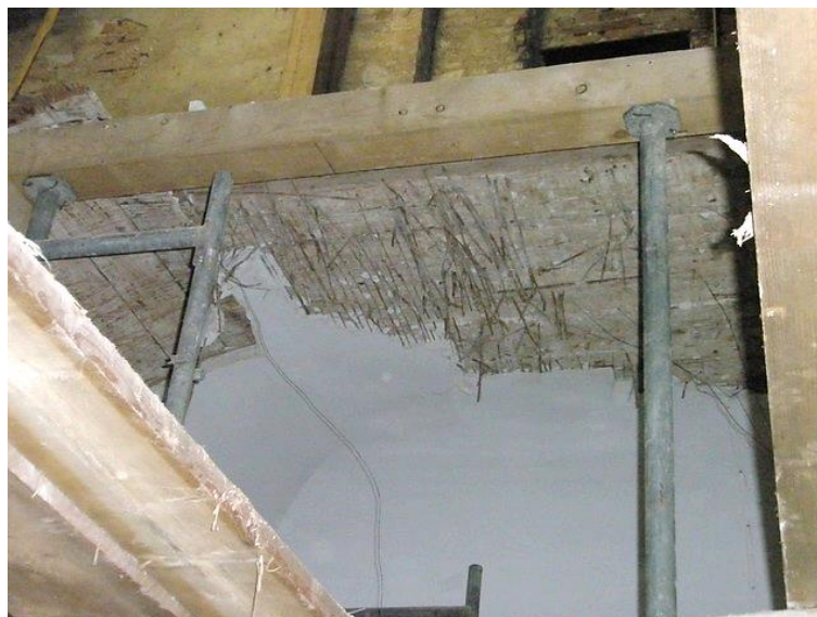
Slika 3.9 Međukatna konstrukcija drvenog grednika
