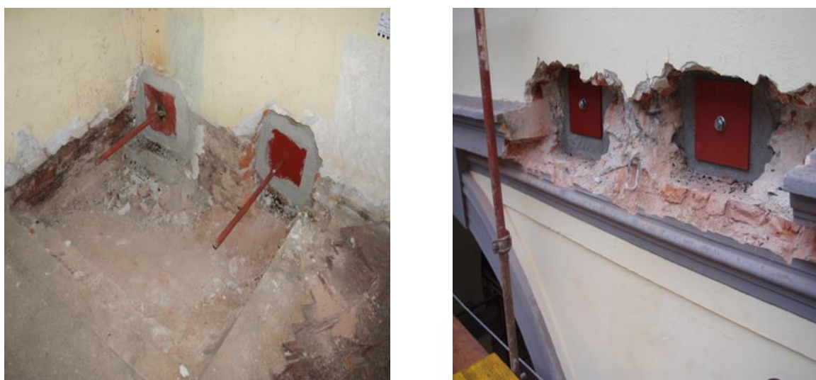
Slika 5.6 Detalj spoja zatege i zida
