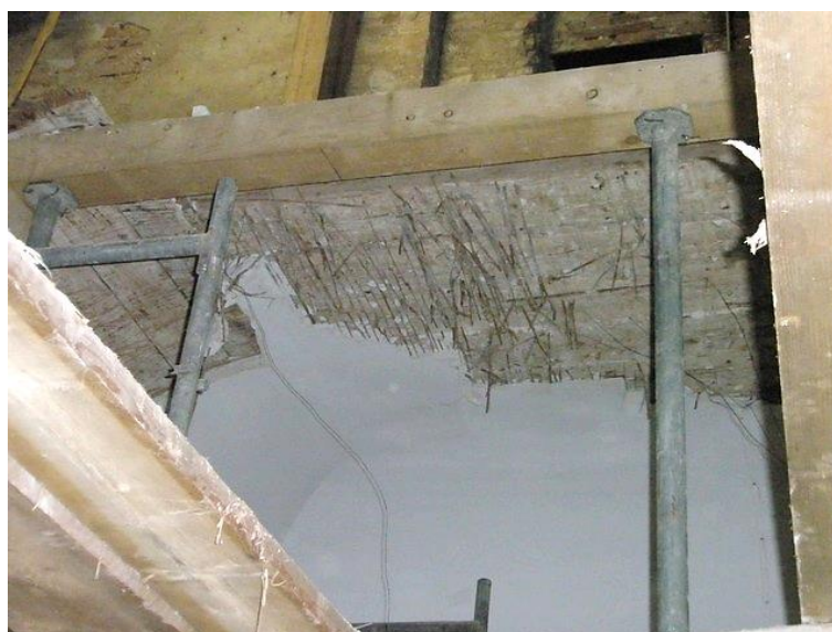
Slika 3.9 Međukatna konstrukcija drvenog grednika
