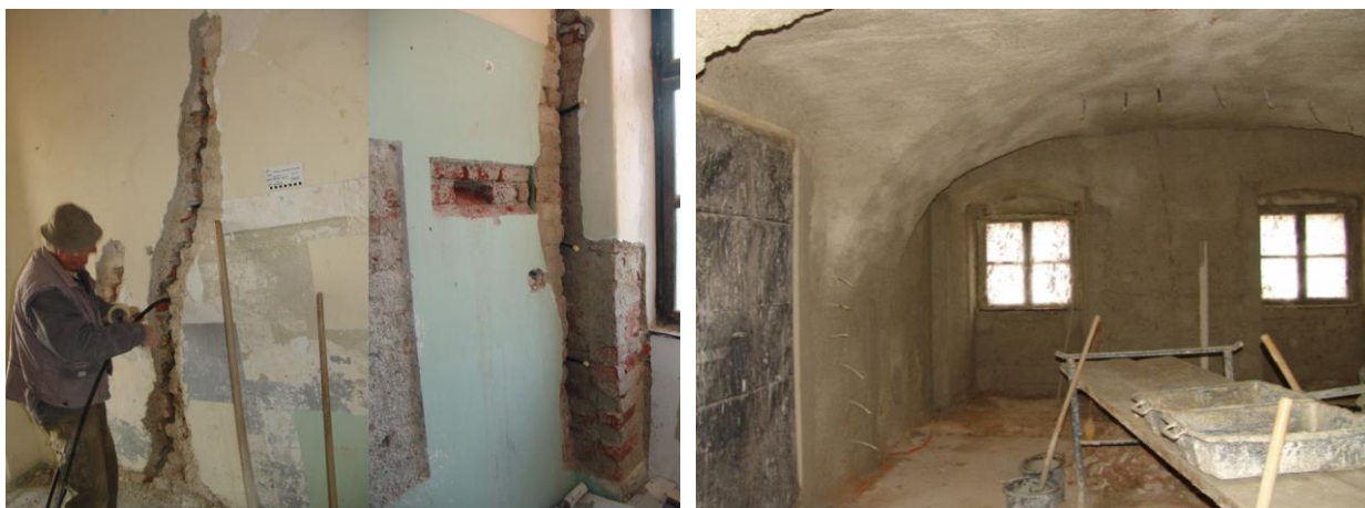
Slika 5.10 Sanacija vanjskih zidova
