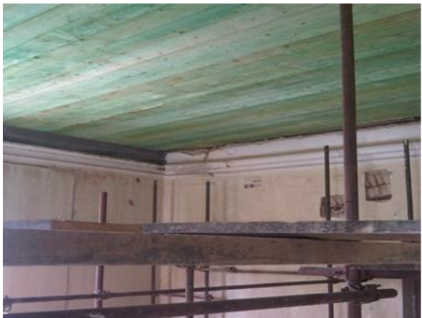
Slika 5.18 Fotodokumentacija rekonstruirane drvene međukatne konstrukcije
