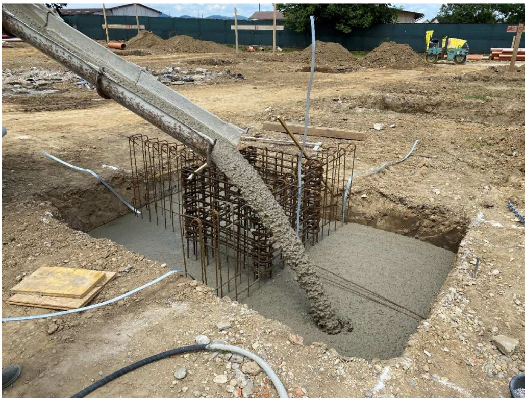
Slika 3 Prikaz ugradnje betona za betoniranje AB stopa montažnih stupova
