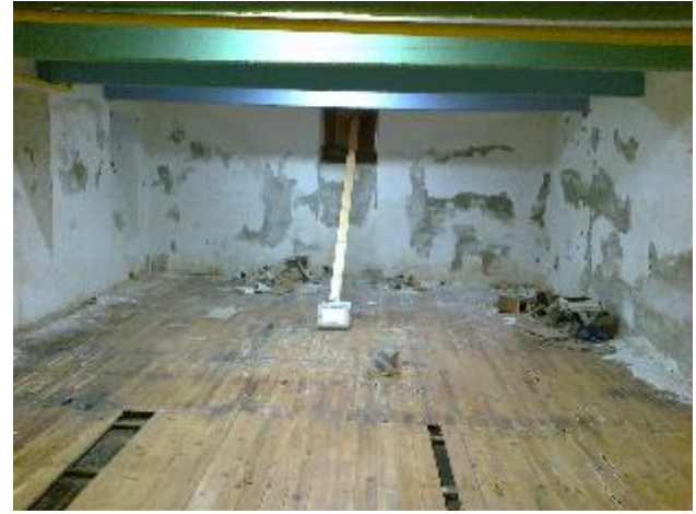
C. Drveni podovi u podrumu (parket u dvorani) su nabrekli i odvojili se od podloge
