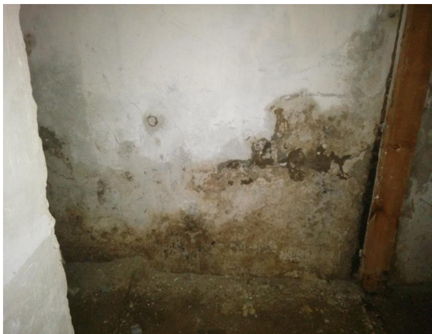
Slika 5.5 Učinci kapilarne vlage u podrumskim zidovima
