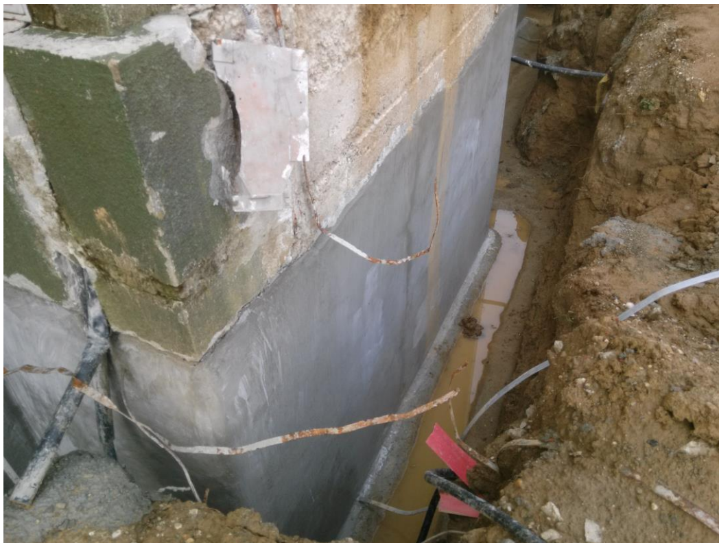
Slika 5.16 Otkopavanje oko zidova i izrada vertikalne hidroizolacije zidova sa dvokomponentnim elastičnim vodonepropusnim premazom, u tri sloja
