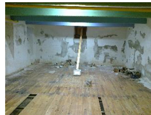
C. Drveni podovi u podrumu (parket u dvorani) su nabrekli i odvojili se od podloge
