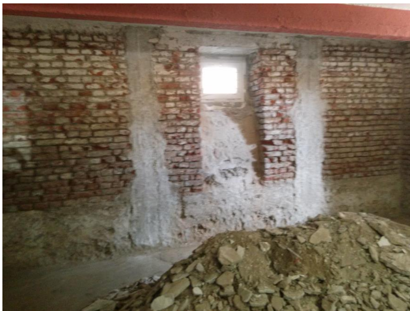
Slika 5.14 Otucavanje kompletne žbuke sa vanjskih zidova predmetne zgrade do pune visine
