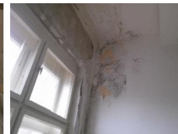
B. Pojava plijesni na zidu
