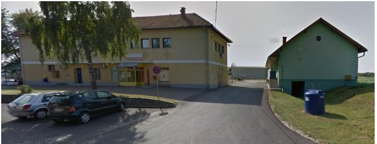
Slika 16. Prikaz starog stanja prije obnove [27]
