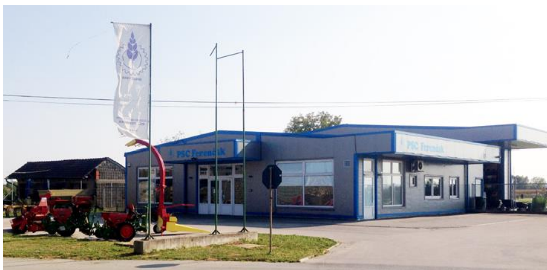
Slika 6. Poslovnica u Bjelovaru
