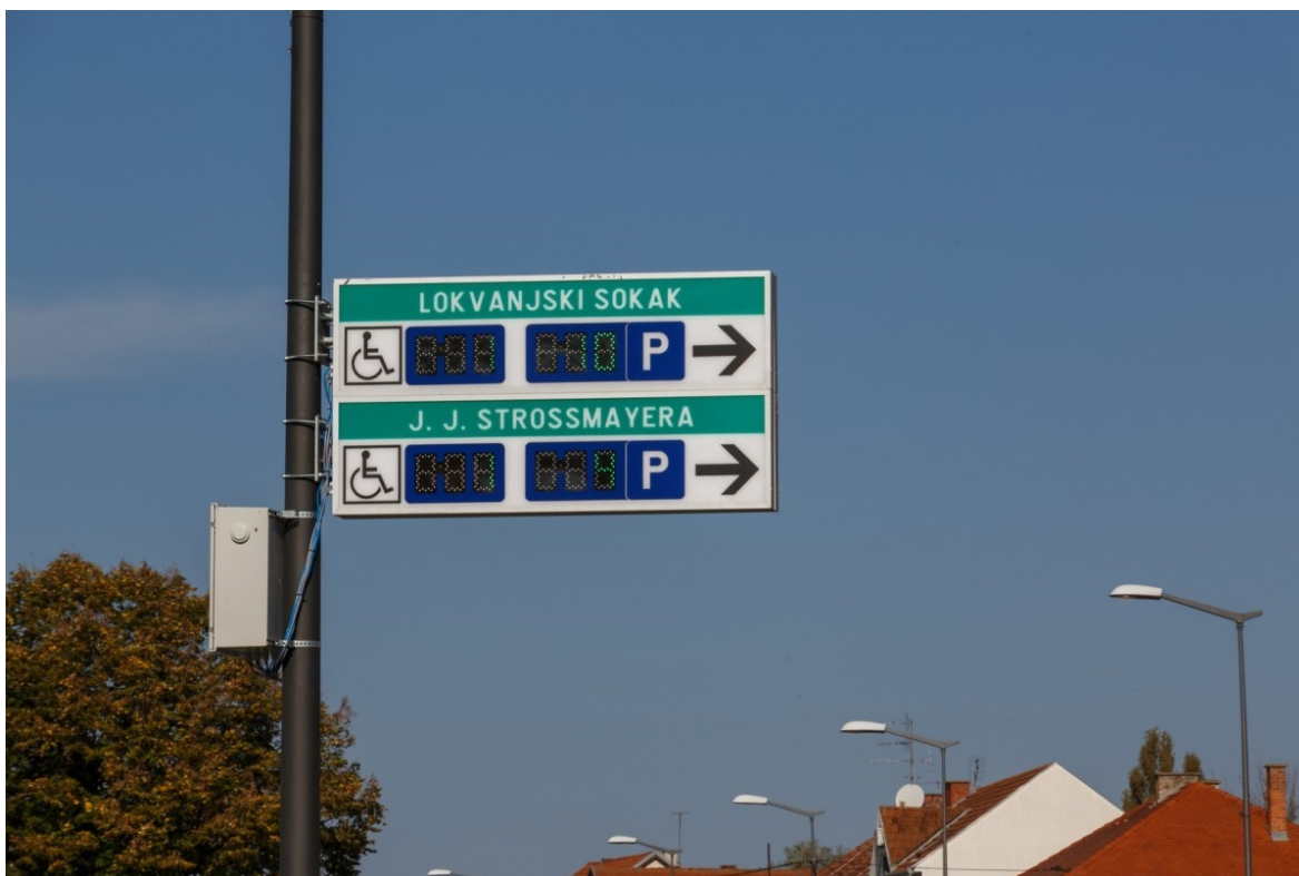
Slika 10. Dinamički znak sa informacijom na zaslonu u numeričkom obliku koja prikazuje točan broj slobodnih mjesta
