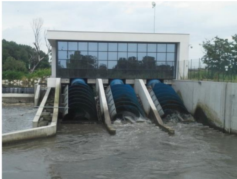
Slika 3.1. Tri paralelna Arhimedova vijka [10]
