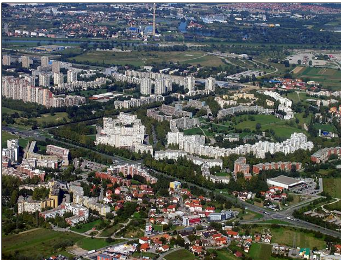
Slika 4.1. Pogled iz zraka na urbano naselje Dugave
