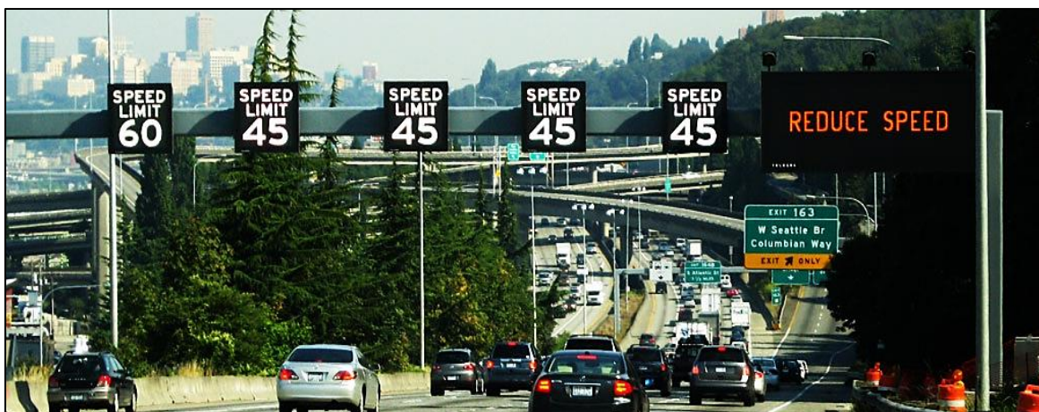
Slika 5.11. Promjenjivi prometni znakovi za reguliranje brzine vozila
