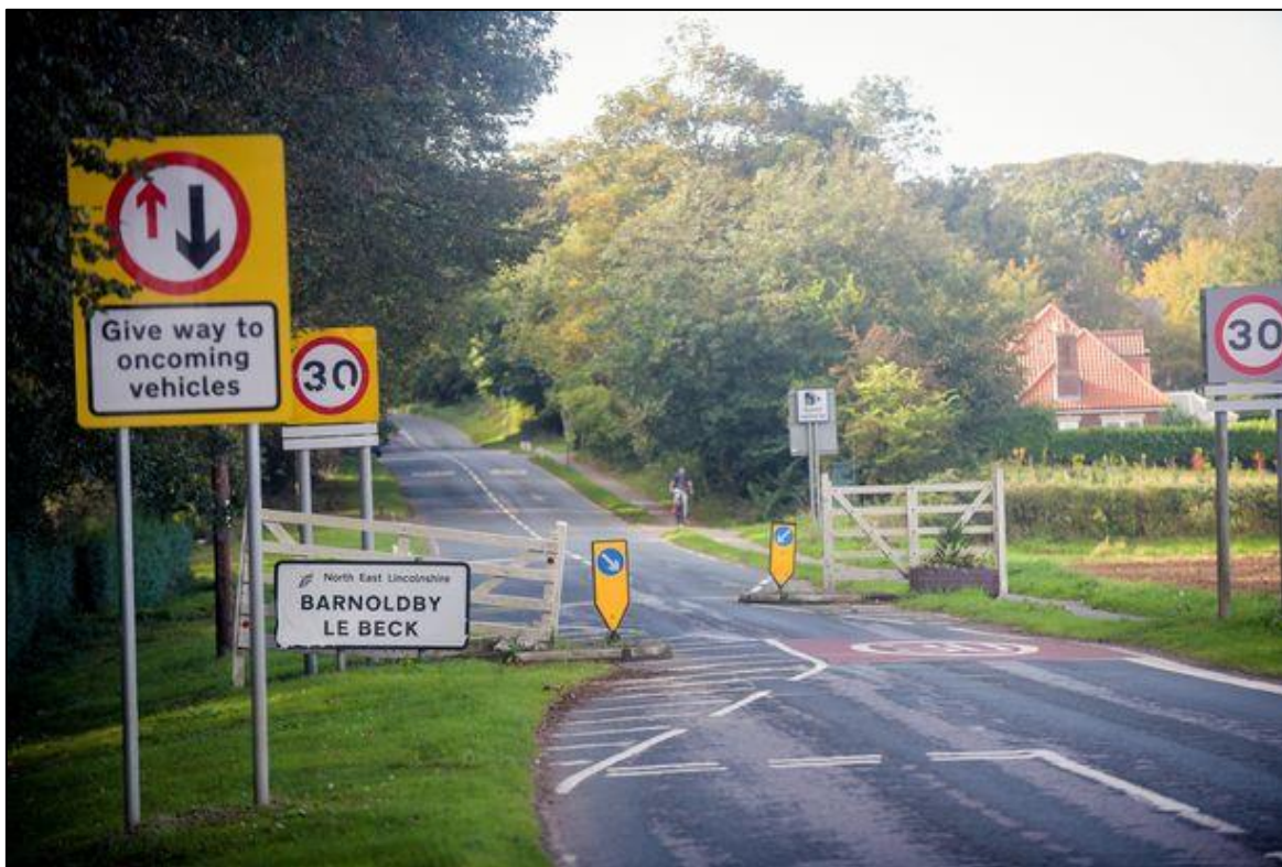
Slika 5.15. Ulazni infrastrukturni tretman za novi režim brzine
