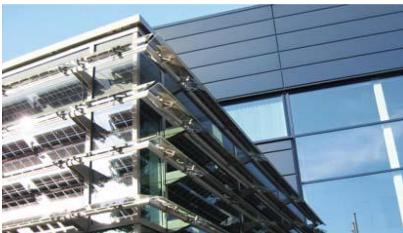
Slika 9. Ugradnja na prozore. Izvor: [9]
