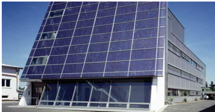
Slika 8. Ugradnja na fasadu. Izvor: [9]
