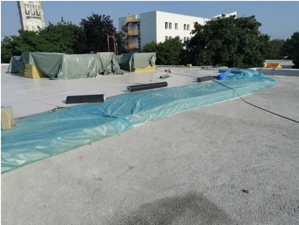
Slika 24. Izvođenje završnog sloja krova od TPO folije [10]
