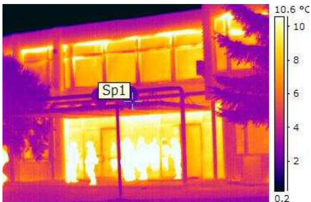
Slika 7. Termografija ulaznog prostora škole [9]
