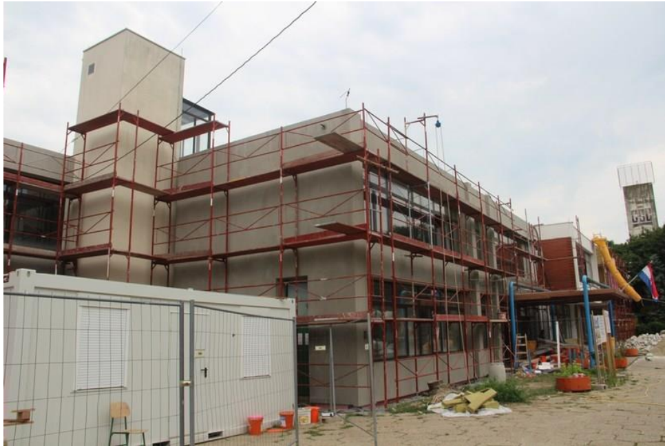
Slika 20. Implementacija polimer-cementnog ljepila armiranog tekstilno-staklenom mrežicom
