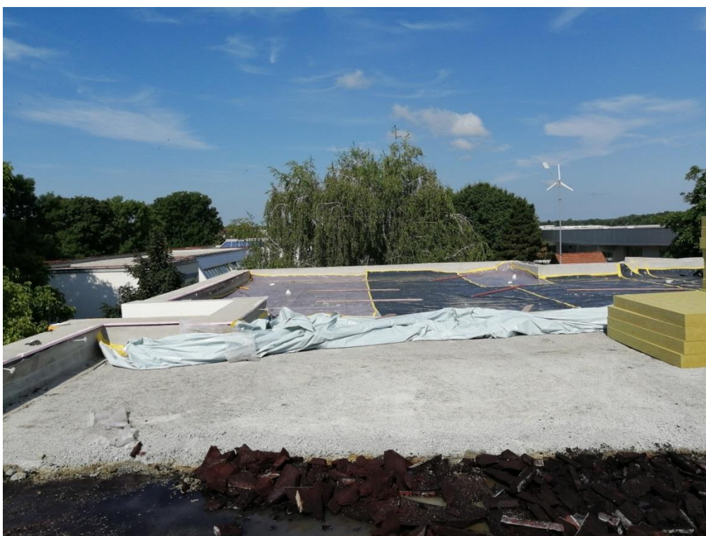
Slika 22. Izvođenje radova na krovu škole [10]
