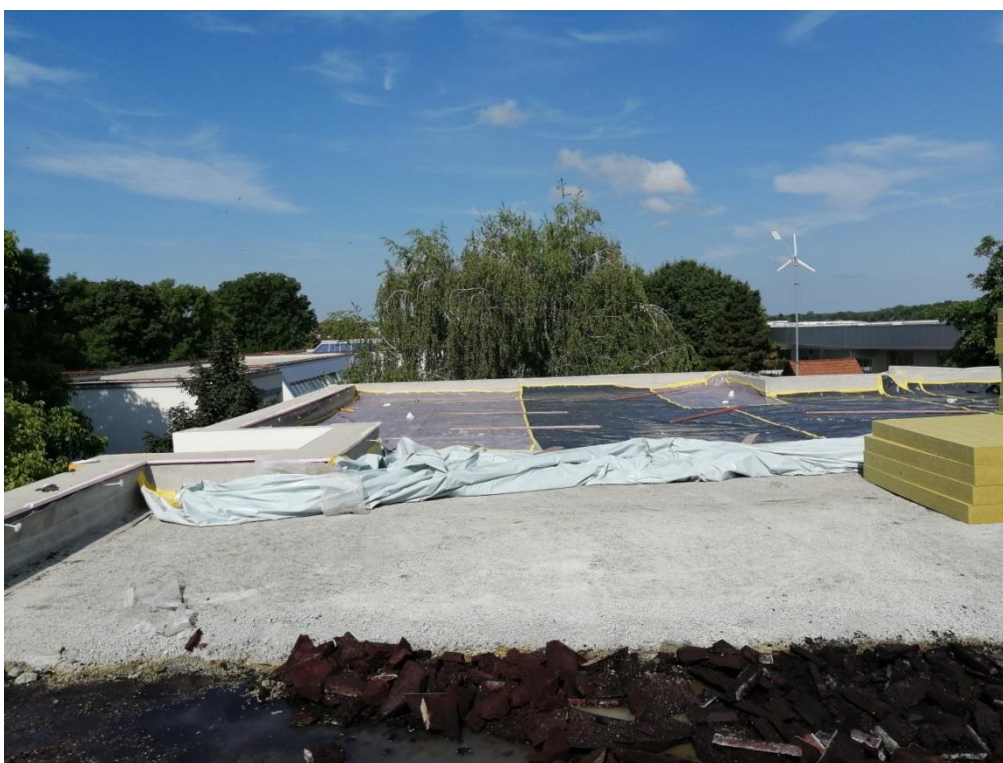
Slika 22. Izvođenje radova na krovu škole [10]
