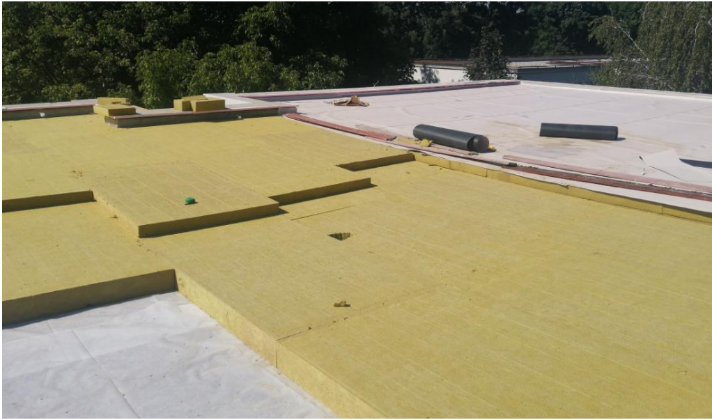
Slika 23. Toplinska izolacija krova [10]
