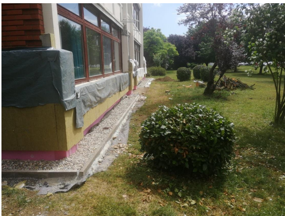
Slika 18. Toplinska izolacija južnog pročelja
