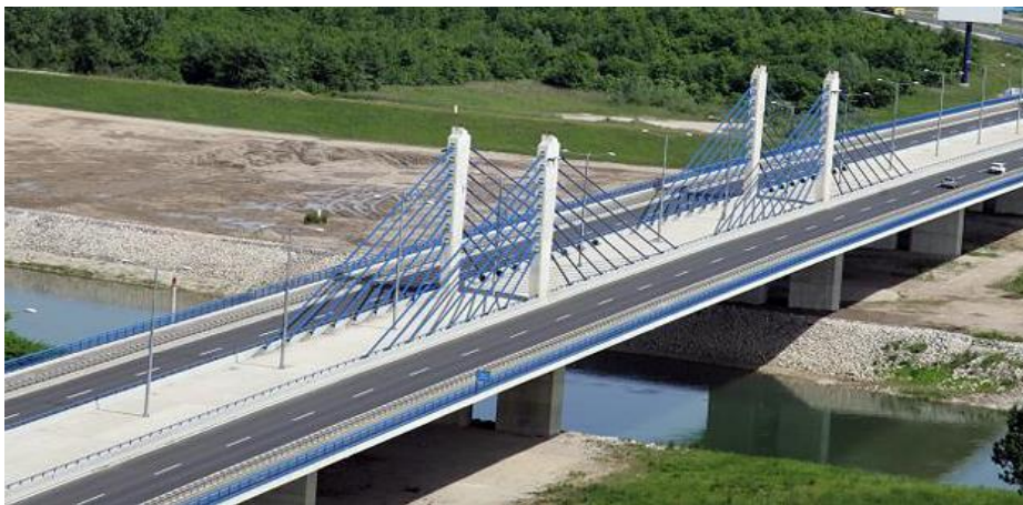
Slika 3. Primjer ovješnog mosta - Domovinski most u Zagrebu [26]
