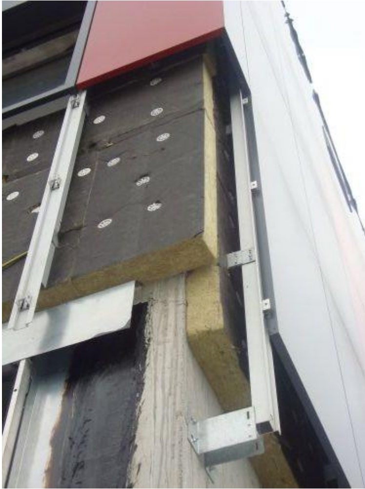
Slika 8.1. Slojevi ventilirane fasade
