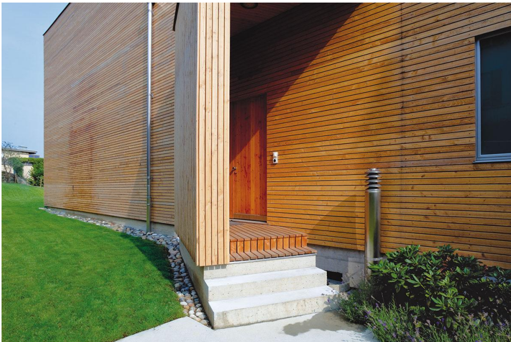
Slika 3.8. Drvena ventilirana fasada,
