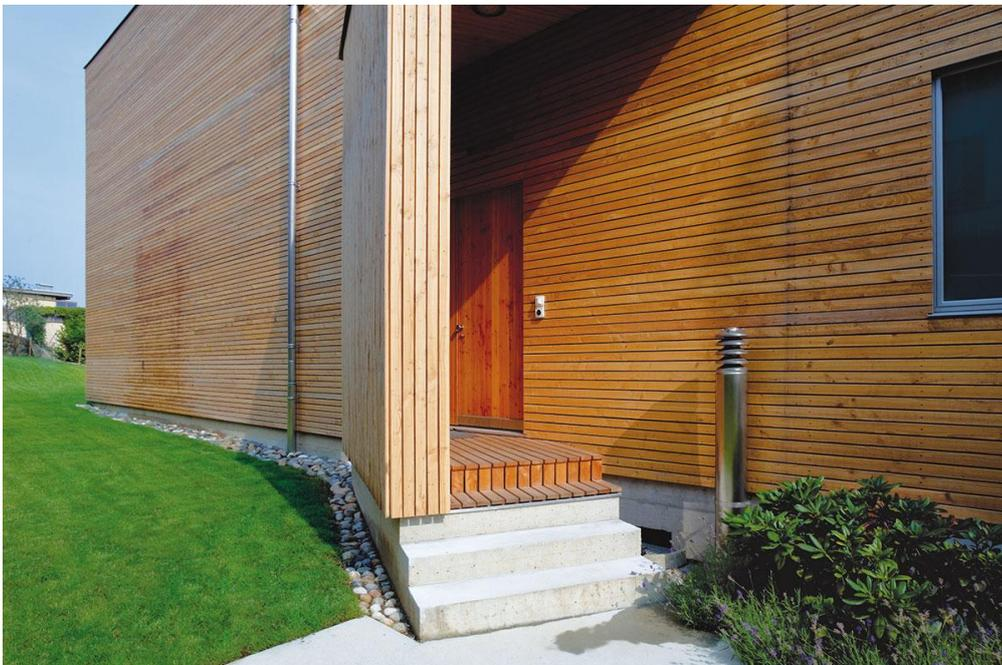
*Slika 3.8. Drvena ventilirana fasada,*
