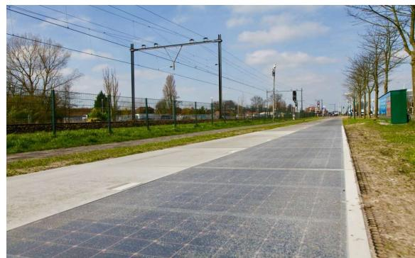
*Slika 3.34 Staza od solarnih panela [22]*
