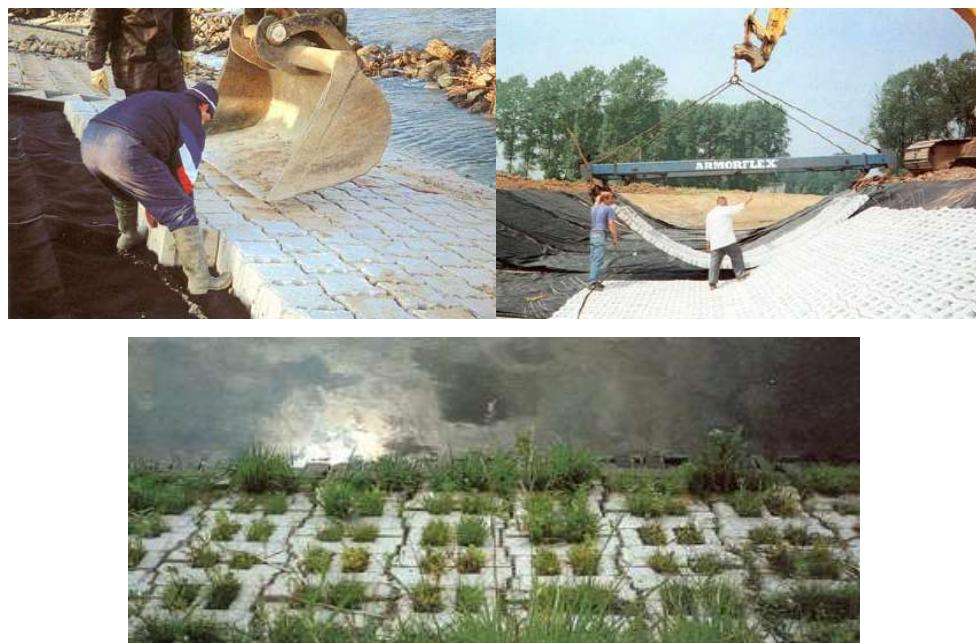
*Slika 3.20 Kose obalouvrde s oblogom od betonskih blokova [7]*
