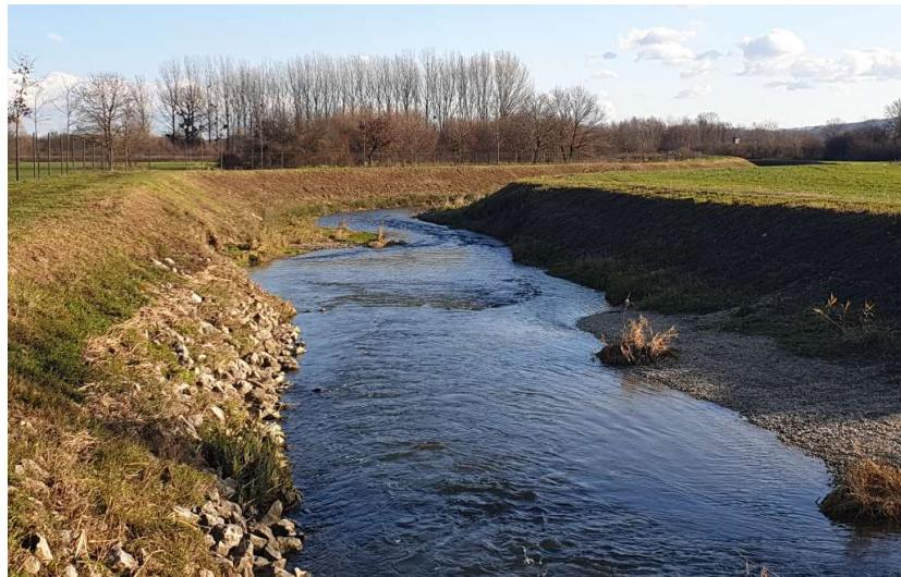
*Slika 4.12 Stara sanacija pokosa kamenom – znak kontinuirane erozije na predmetnoj poziciji; vidljive manje erozije u saniranom segmentu [2]*
