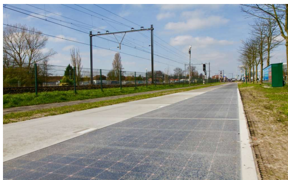
Slika 3.34 Staza od solarnih panela [22]
