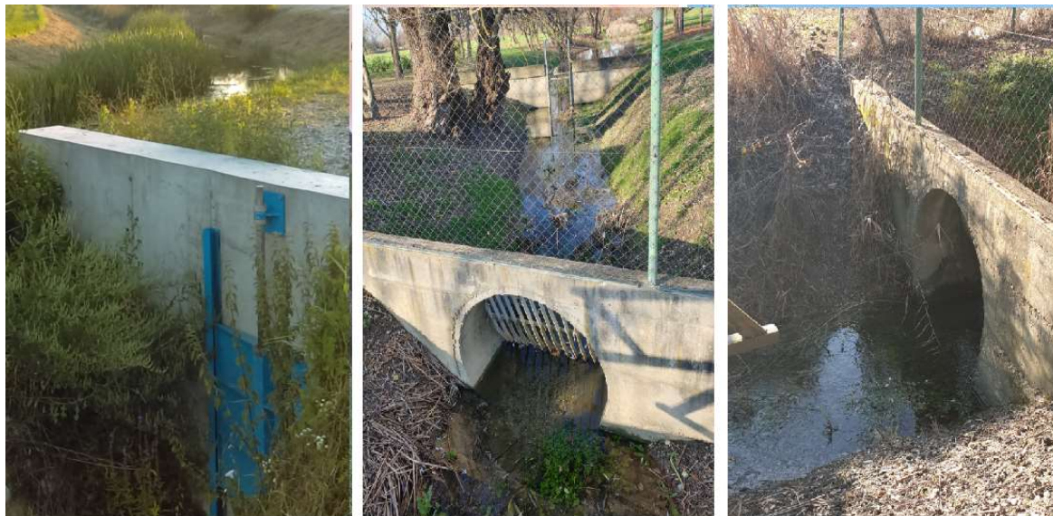
Slika 4.14 Zapornica na potoku Gojančica, kanalu Brezje i Dvor [2]
