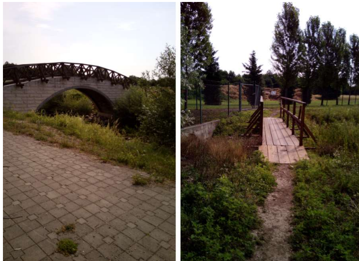
Slika 2.10 Pješački most – lijevo, Most preko pritoke/potoka – desno [1]
