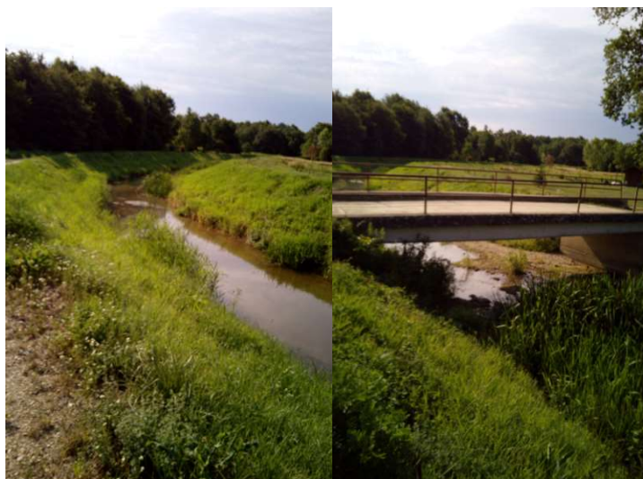
Slika 2.7 Pogled nizvodno – lijevo i most „Gojanec“ rkm 43+075 m – desno [1]
