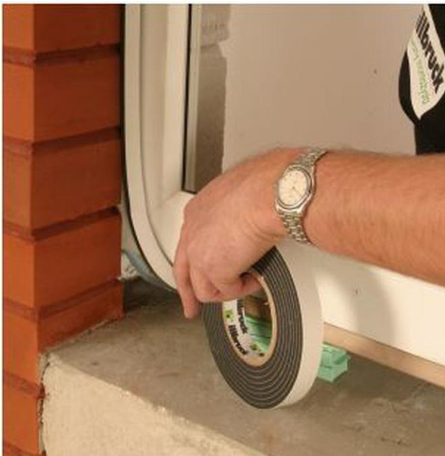
Slika 5.4.1 Brtvljenje prozora ekspanzivnom trakom radi zrakonepropusnosti [33]
