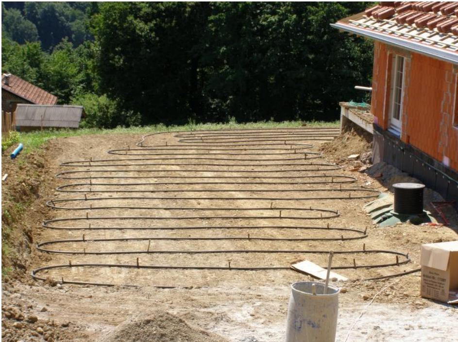
Slika 7.2.1 Prikaz dobivanje topline od površinske zemlje [37]
