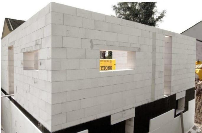
Slika 3.6.1.1 Prikaz gradnje porobetonom [26]
