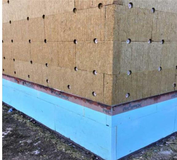
Slika 3.5.1 Izoliranje mineralnom vunom i xps-om [18]
