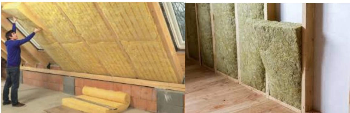
Slika 4.4.3 Postavljanje staklene i kamene vune [21]
