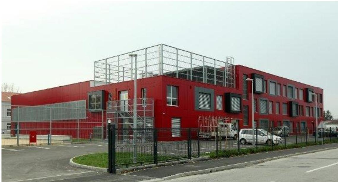
Slika 3.6.3 Primjer ventilirane fasade [7]
